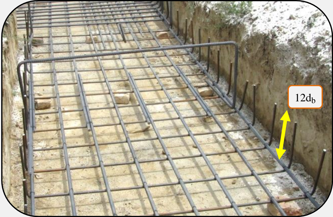
(طول مستقیم پس از خم قلاب ۹۰ درجه برای مهار میلگردهای عرضی به قطر ۱۸ تا ۲۵)
