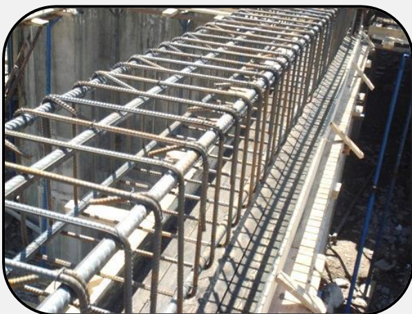
(آرماتوربندی تیر بتنی)
