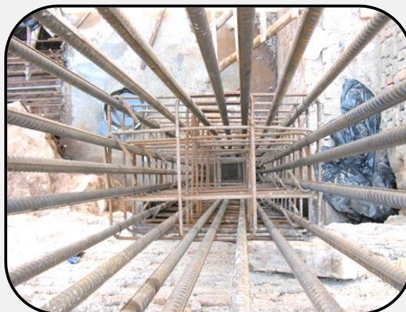
(آرماتوربندی ستون بتنی)
