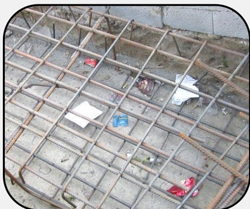
(مواد زائد درون قالب‌بندی و آرماتوربندی)
