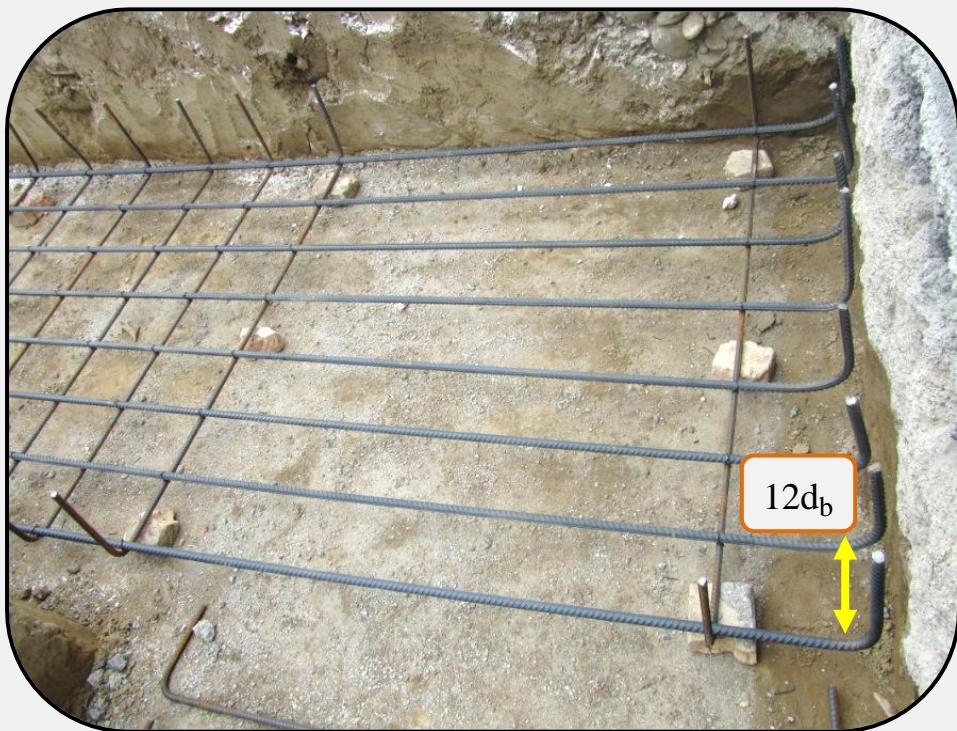
(طول مستقیم پس از خم قلاب ۹۰ درجه برای مهار میلگردهای طولی آجدار در کشش)
