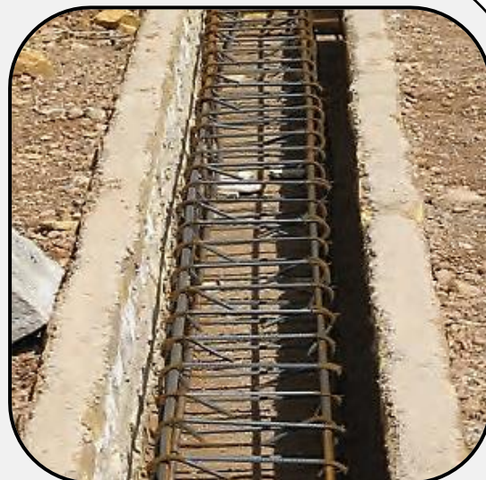
(اجرای میلگردهای شناژها)
