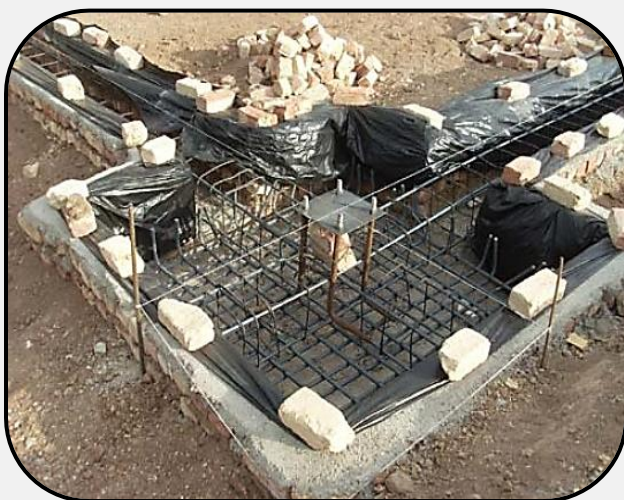
(کارگذاری بیس‌پلیت برای سازه‌های فولادی)
