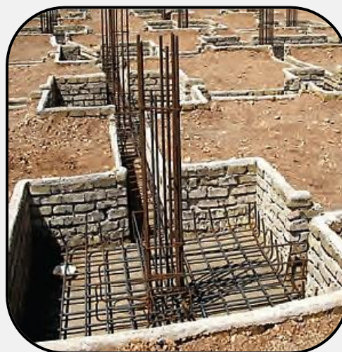
(اجرای میلگردهای ریشه انتظار برای سازه‌های بتنی)
