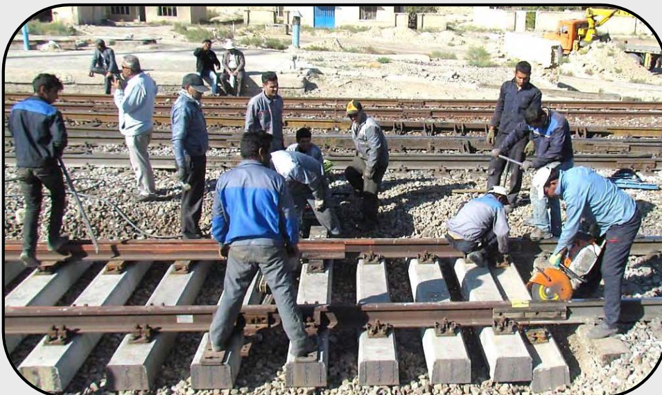
تعویض تراورس‌های چوبی خط و نصب تراورس‌های بتنی
