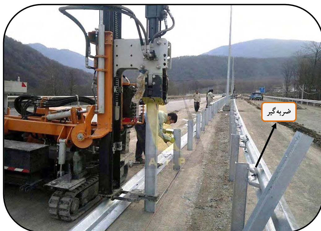
دستگاه گاردکوب جهت اجرای گاردریل راهسازی
