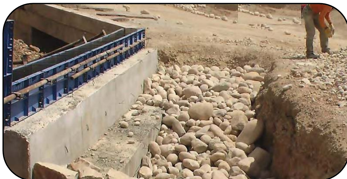
سنگ‌ریزی پشت دیوارها و پل‌ها (درناژ) با سنگ قلوه
