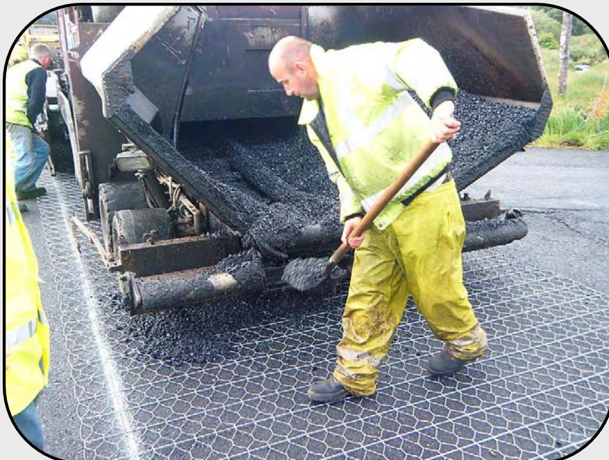
اجرای ژئوگرید جهت مسلح سازی آسفالت
