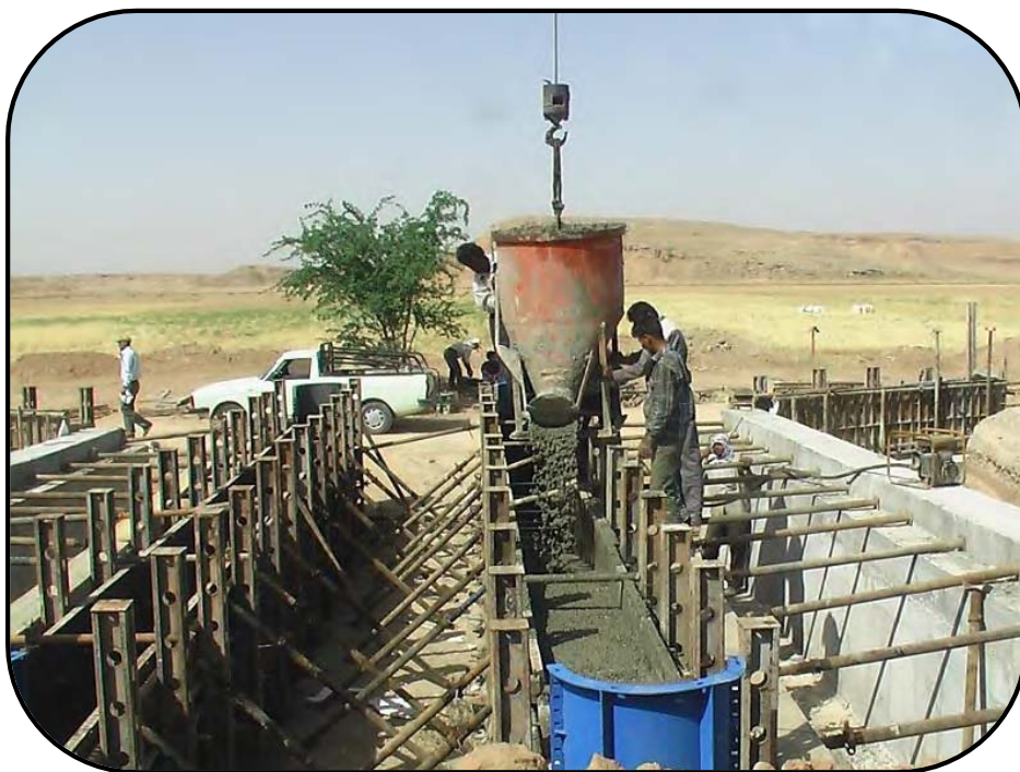
بتنریزی از پی به بالا در دیوارها و پایه پلها
