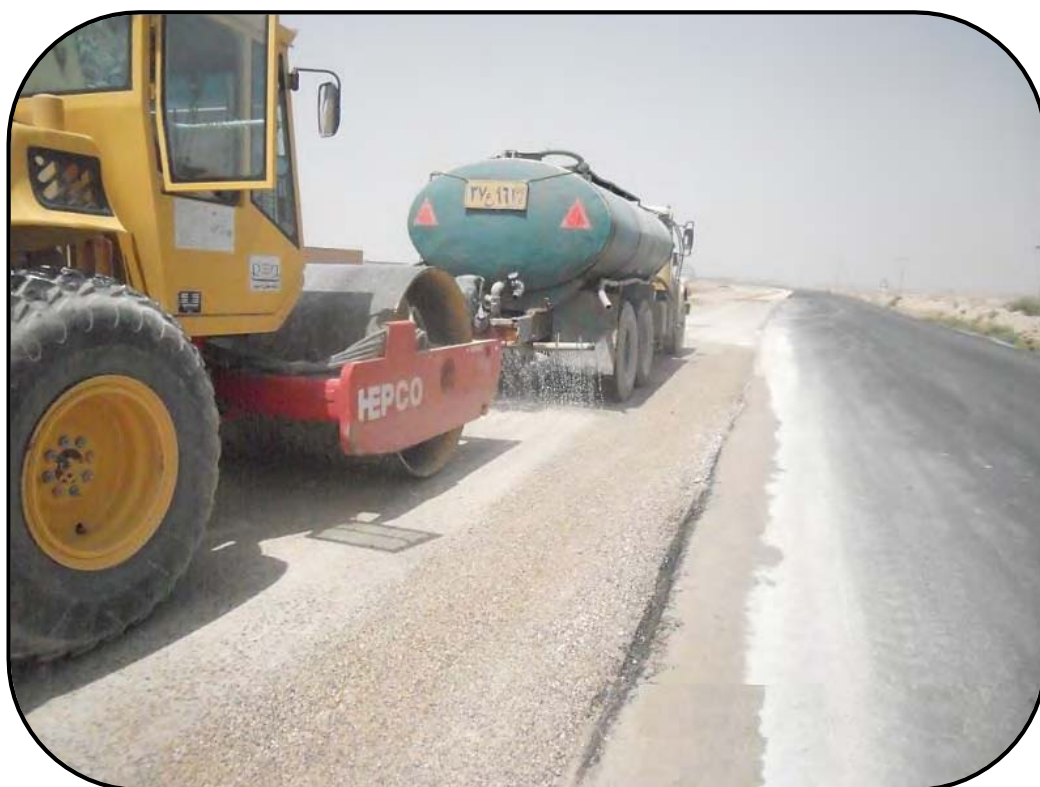
آب پاشی و کوبیدن لایه اساس
