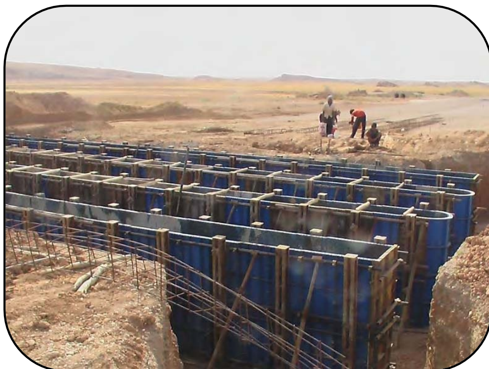
قالب بندی دیوار بتنی
