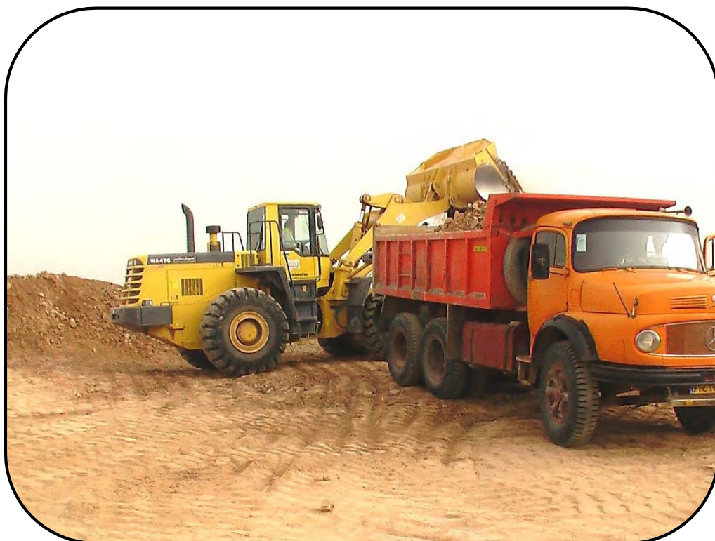
عملیات خاکبرداری و حمل
