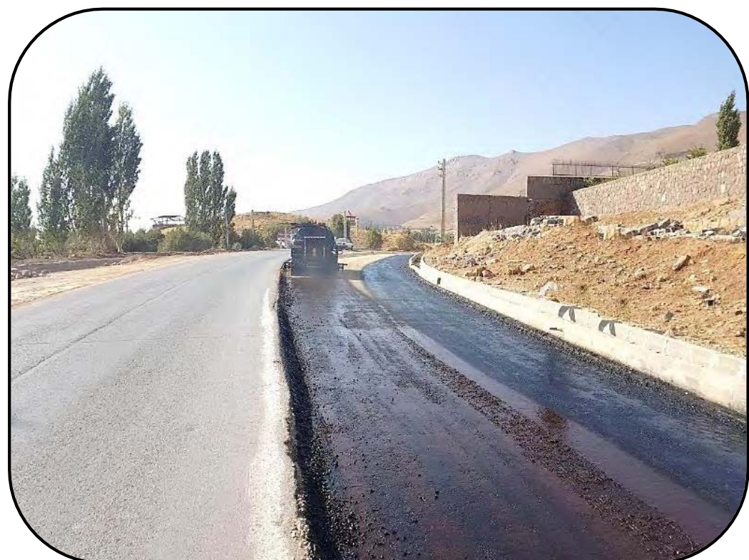
اجرای اندود نفوذی (پریمکت)
