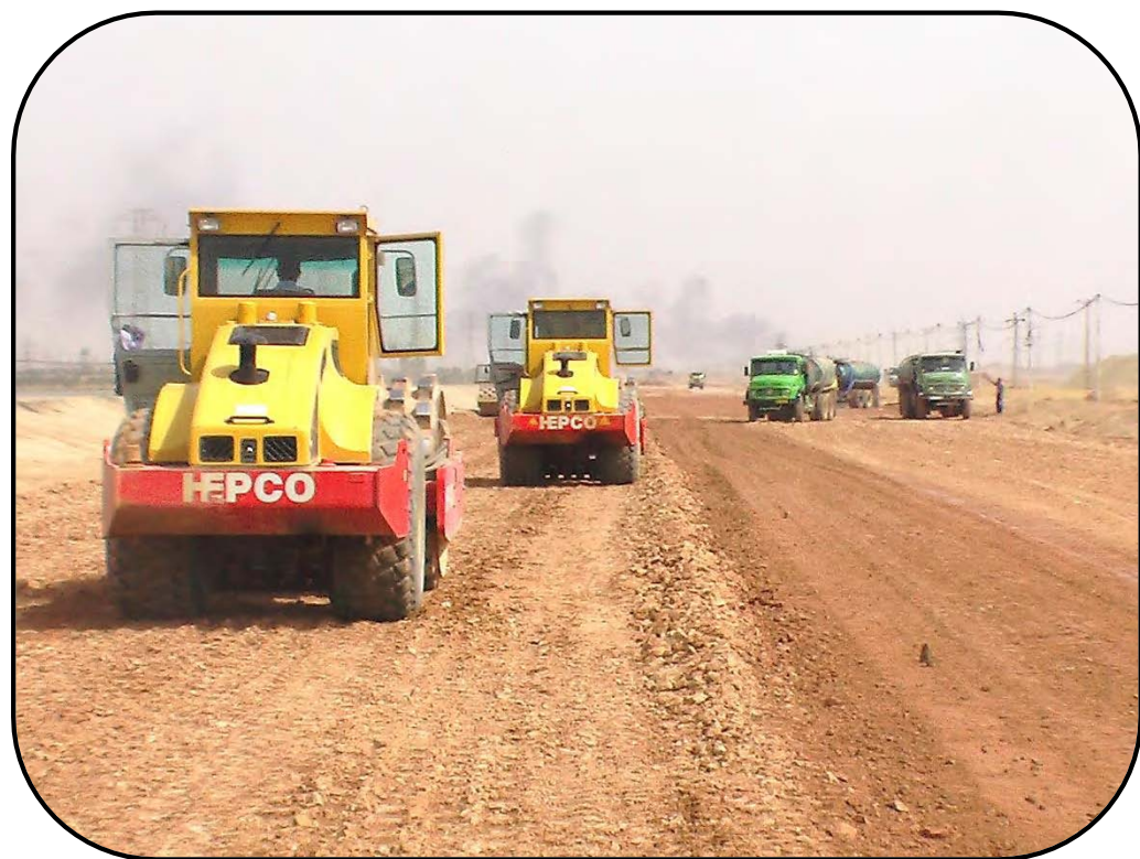
پخش، آب پاشی، تسطیح، پروفیله کردن و کوبیدن قشرهای خاکریز
