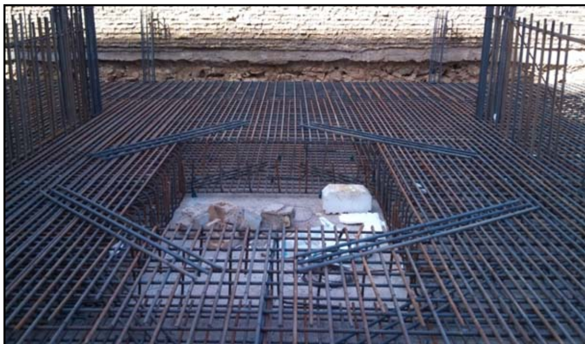
(آرماتوربندی ناحیه چاله آسانسور)
