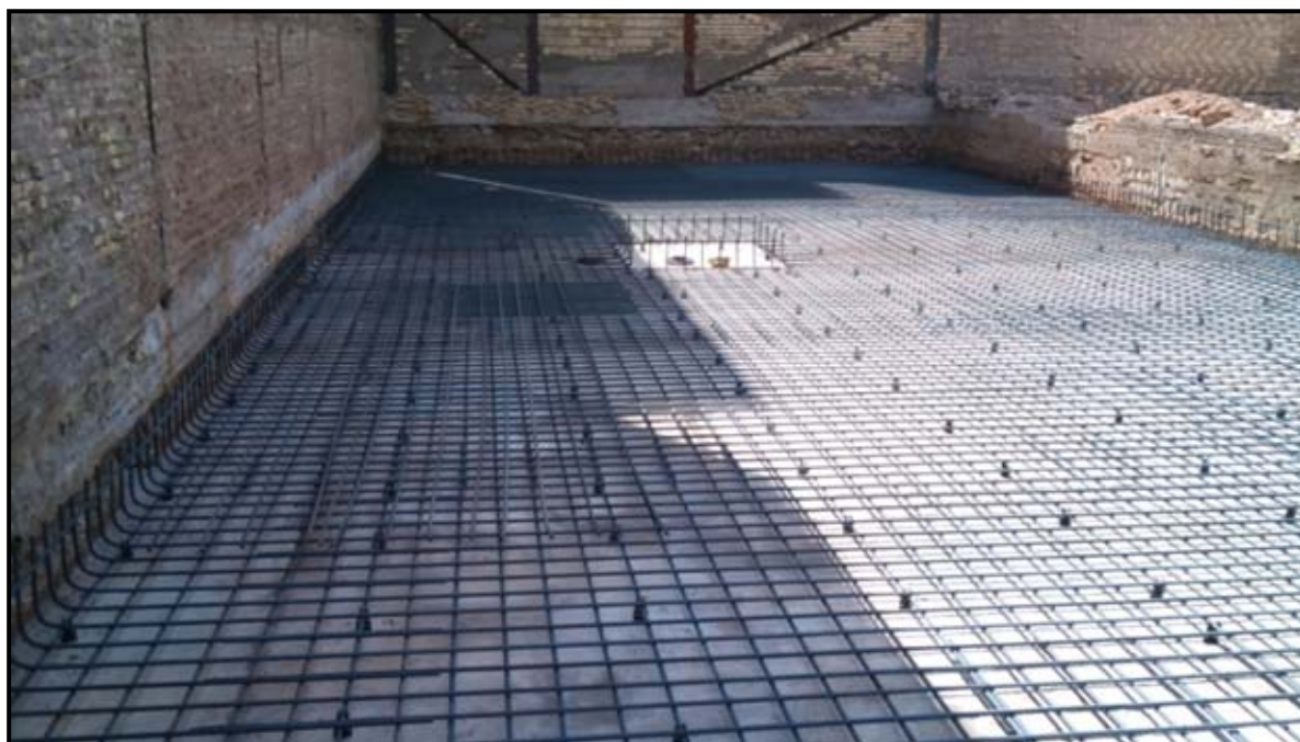
(شبکه آرماتورهای تحتانی فونداسیون گسترده)
