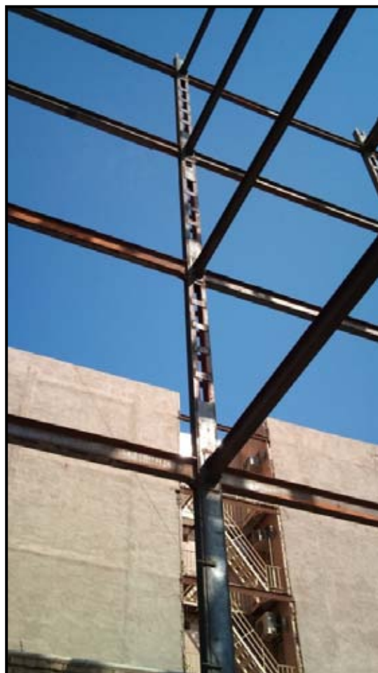
(اجرای ستون و تیر فلزی به همراه بست و ورق تقویتی)
