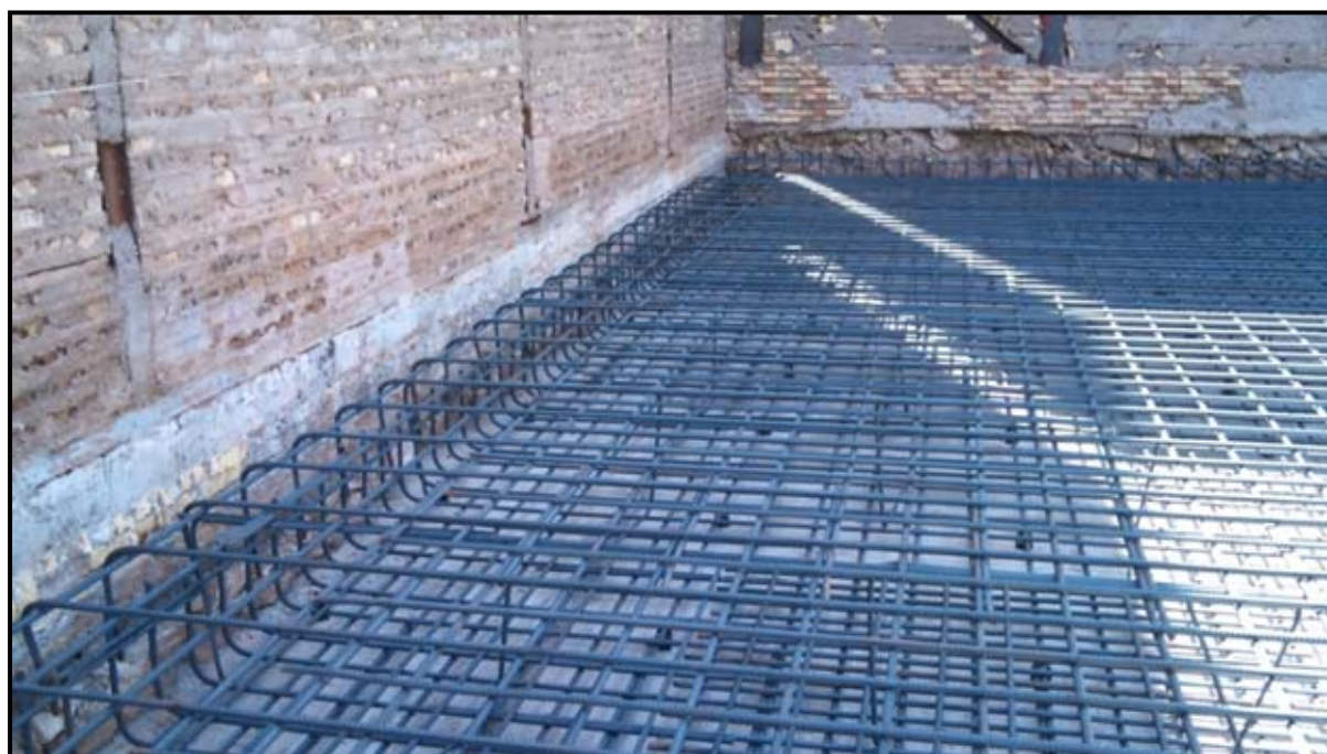
(شبکه آرماتورهای تحتانی و فوقانی فونداسیون گسترده)
