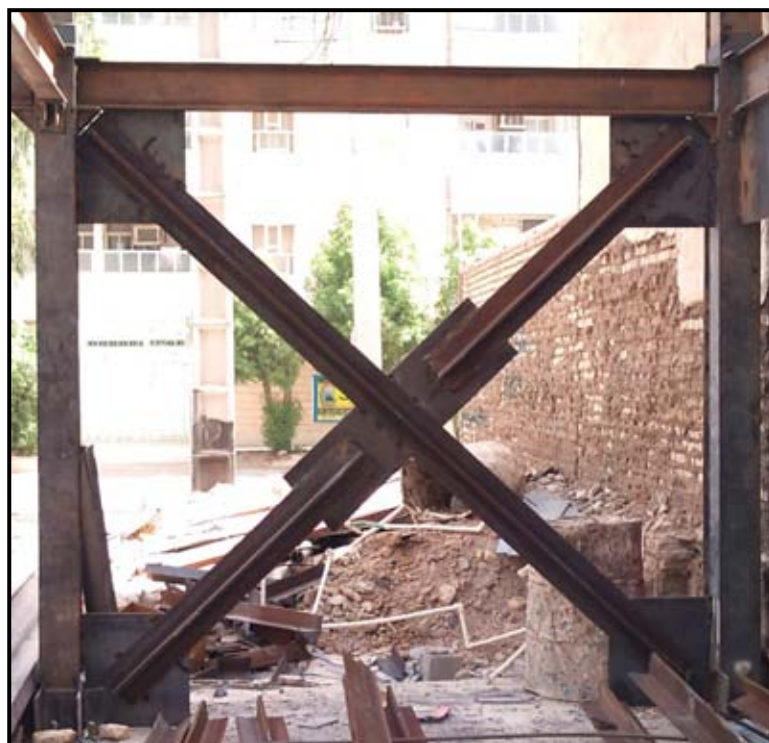
(اجرای بادبند ضربدری)
