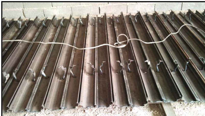
(آماده‌سازی چهارچوب‌های درب)
