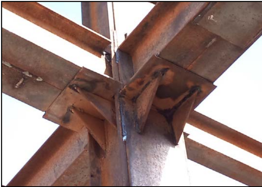
(اتصال تیر به ستون به همراه سخت کننده‌ها و ورق زیرسری)
