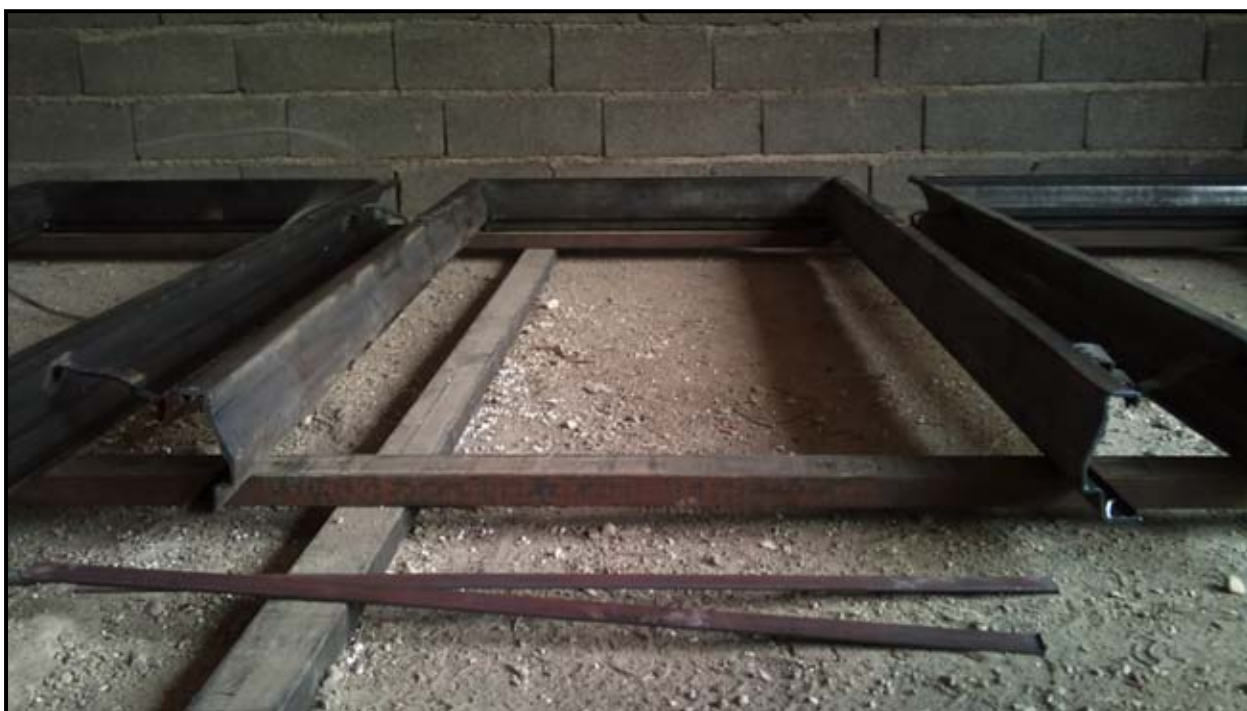
(اجرای چهارچوب فلزی درب با پروفیل های مقطع باز فرانسوی)
