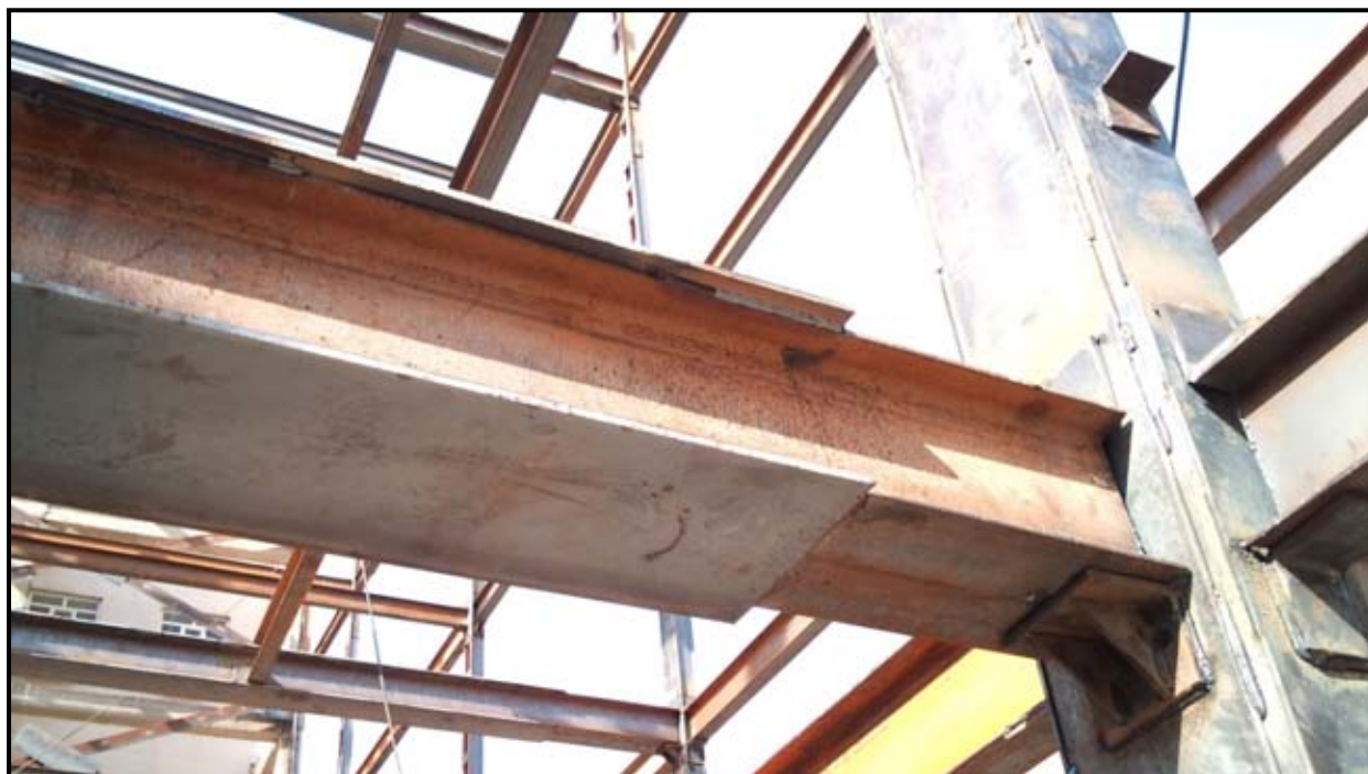
(اتصال تیر فلزی دابل به ستون به همراه ورق های تقویتی)
