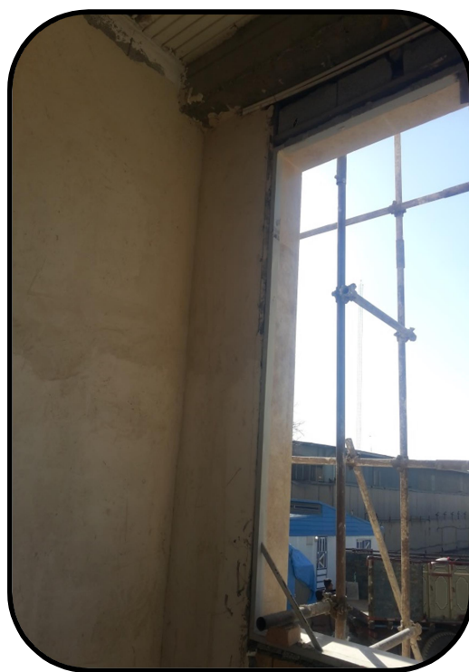
شکل ۱) عدم نصب قاب فلزی دور پنجره
