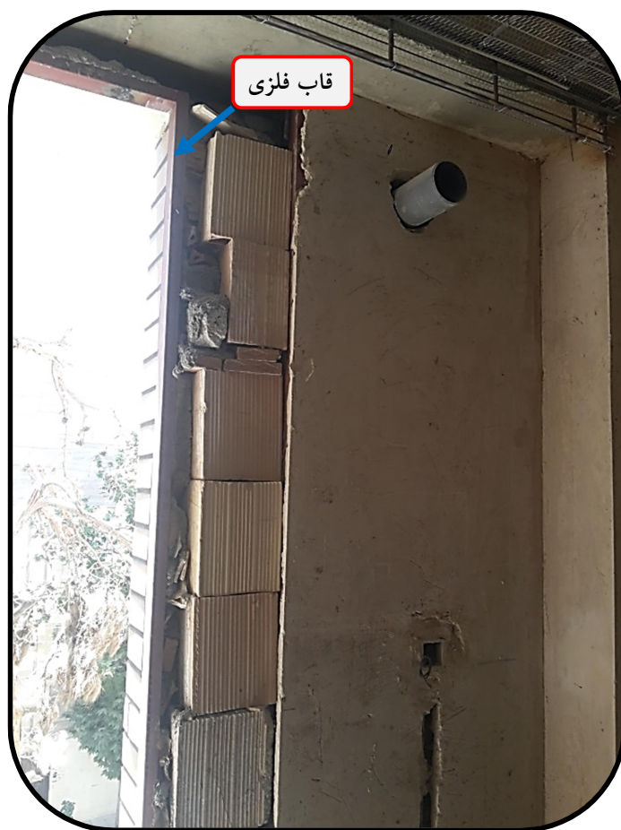
شکل ۴) نصب قاب فلزی دور پنجره
