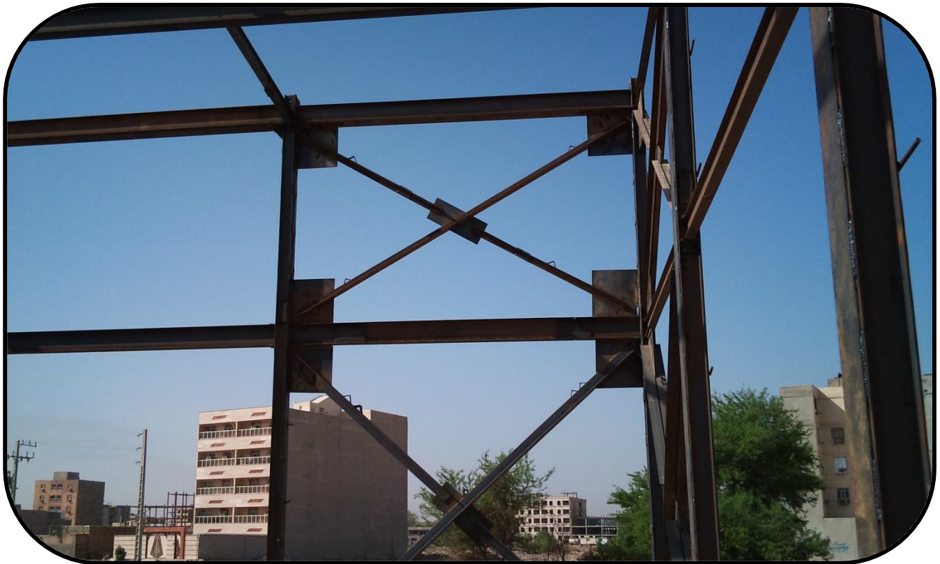
شکل (۱) مهاربند ضربداری
