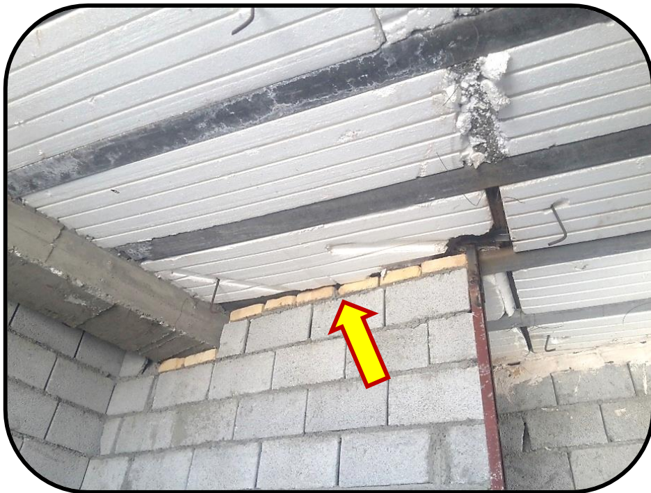
شکل ۱) اتصال دیوار به زیر سقف با آجر
