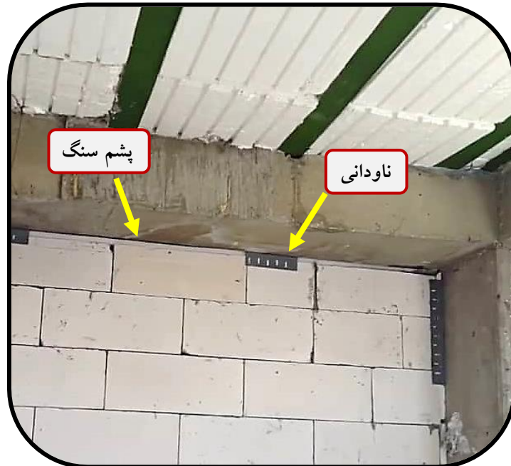
شکل ۴) اتصال دیوار بین قابی به سقف با استفاده از ناودانی
