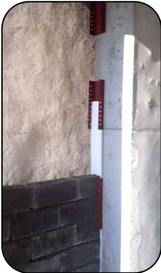
شکل ۴) اتصال صحیح دیوار به ستون با ناودانی و یونولیت
