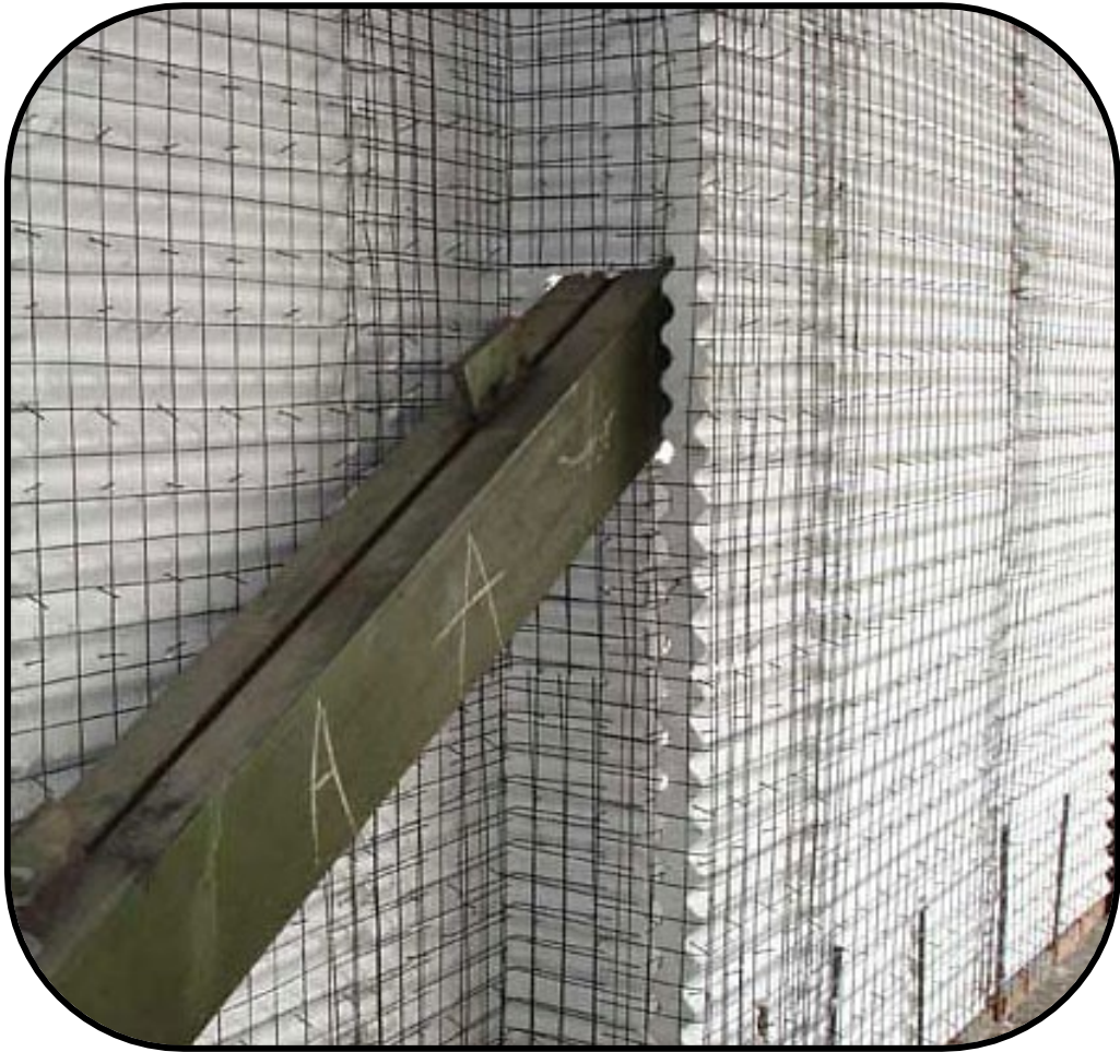
شکل ۳) اجرای تری دی پنل در دهانه مهاربندی
