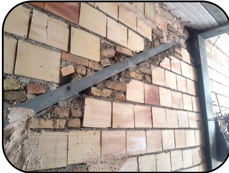
شکل ۱) دیوارچینی روی محور مهاربند
