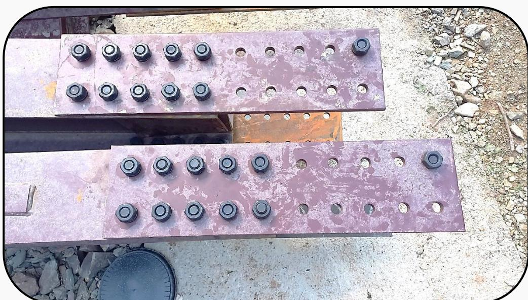
(استفاده از پیچ پر مقاومت ۱۰.۹ در این اتصال)
