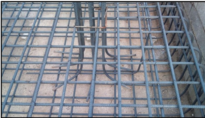
(آرماتورهای انتظار در فونداسیون)
