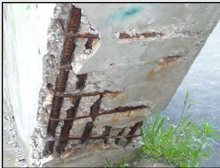
(عدم رعایت کاور مناسب و خوردگی میلگرد)
