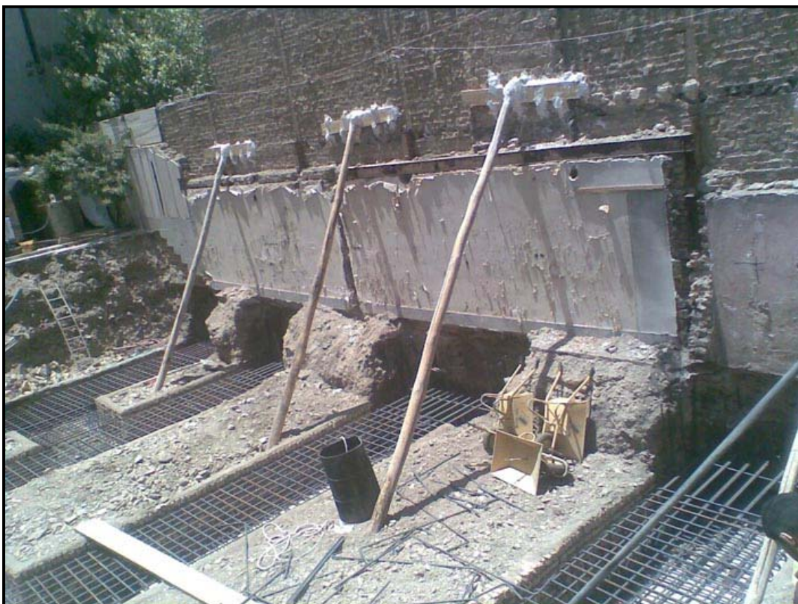
(نمونه مضحکی از مهار ساختمان مجاور)
