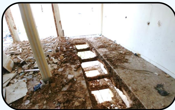
شکل (۱۱-۱) تعبیه سوراخ در سقف‌های طبقات جهت انتقال نخاله‌های حاصل از تخریب به پایین
