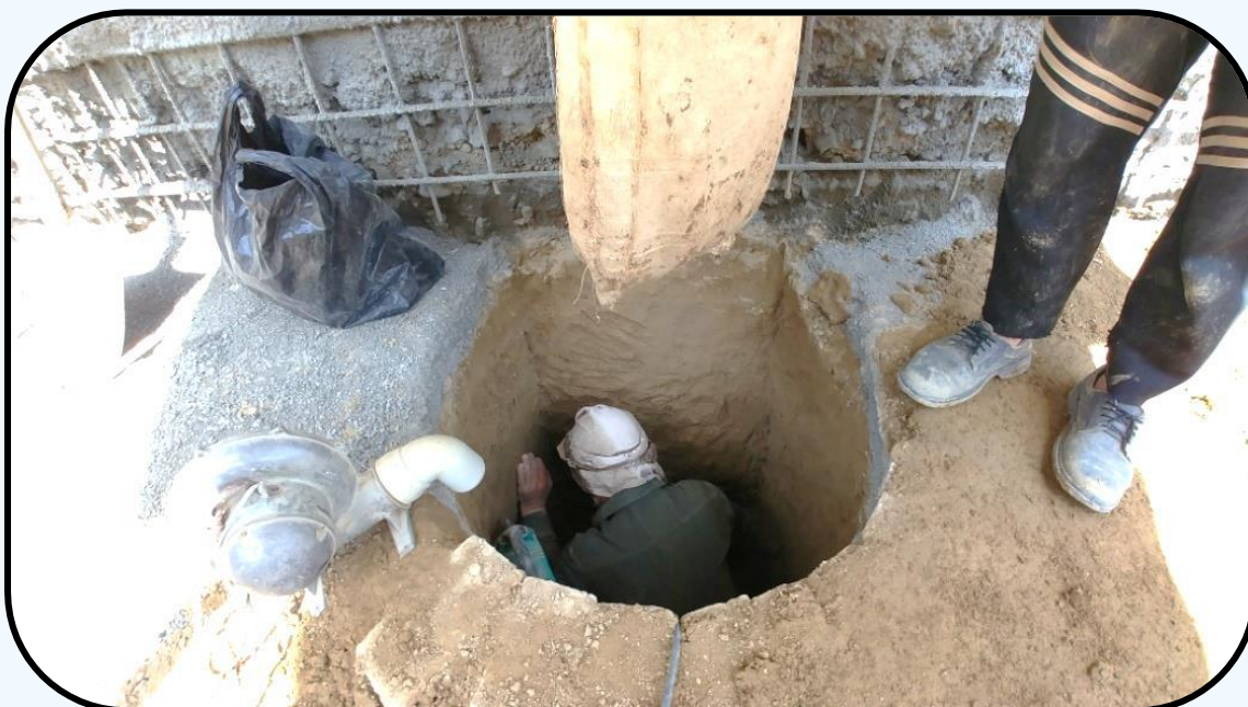
شکل (۱۴-۱۰) حفاری چاه‌های عضوهای قائم سازه نگهدار خرابایی
