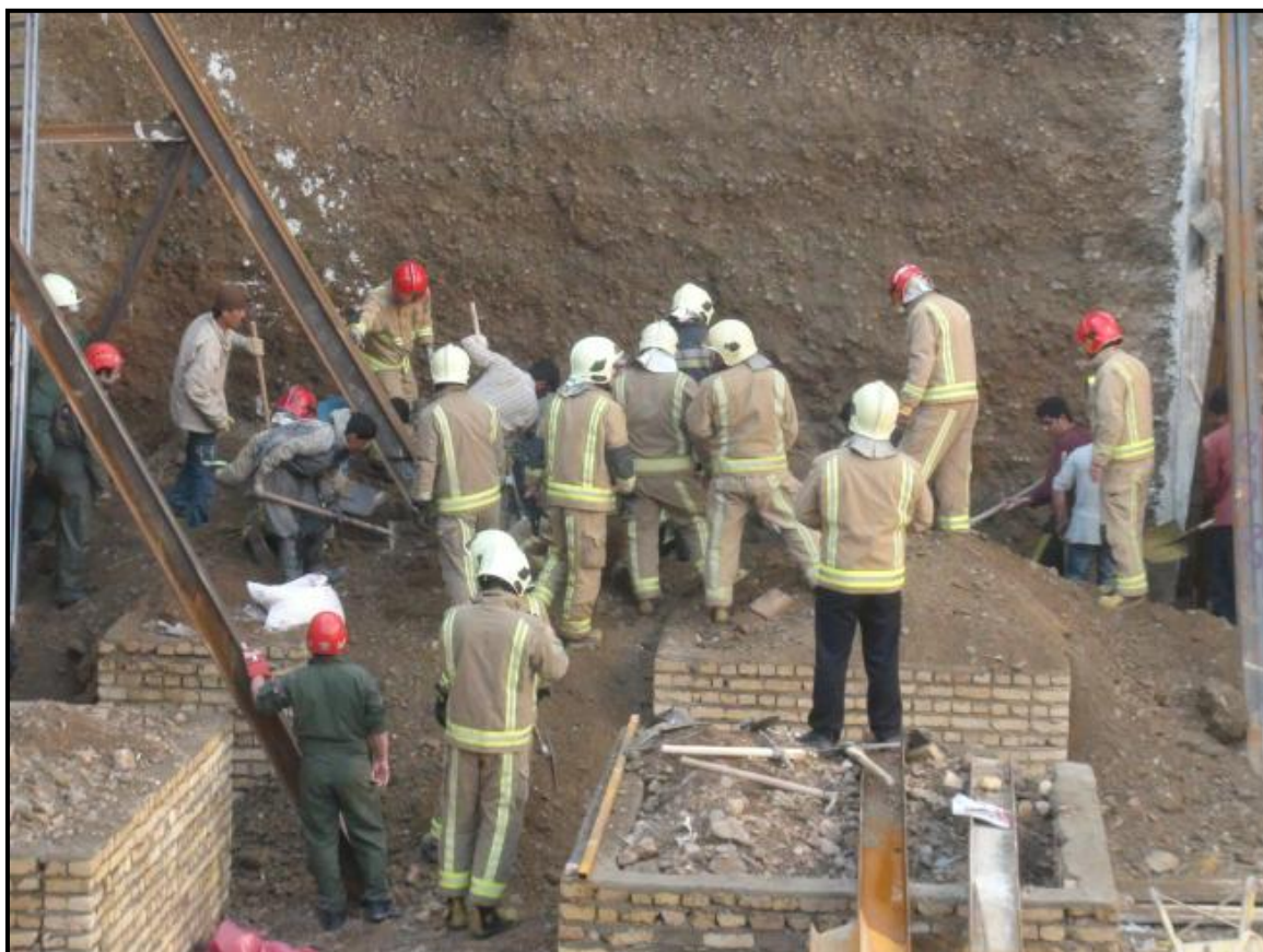
(مرگ کارگر به دلیل عدم رعایت اصول گودبرداری)
