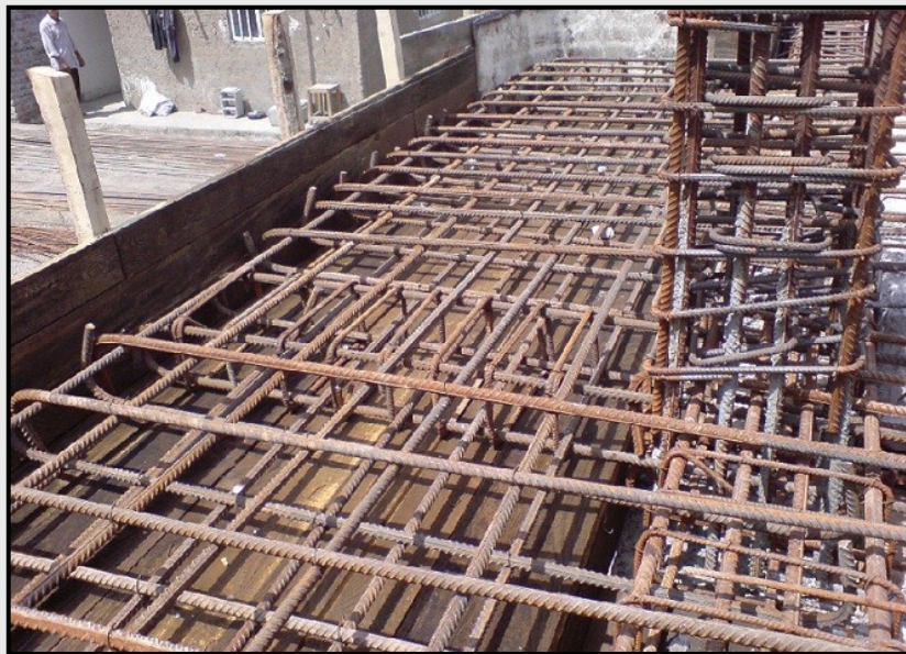
(آرماتوربندی دال بتنی)
