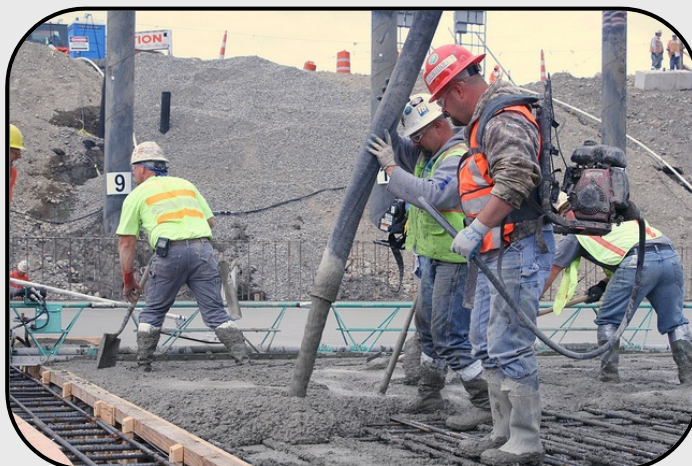
(انتقال بتن با استفاده از شوت سقوطی)
