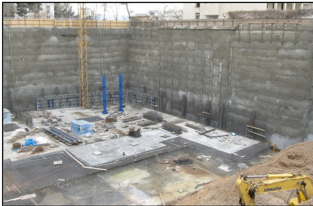
(عمق گود ۲۵ متر - پایدارسازی گود با شمع و مهار)
