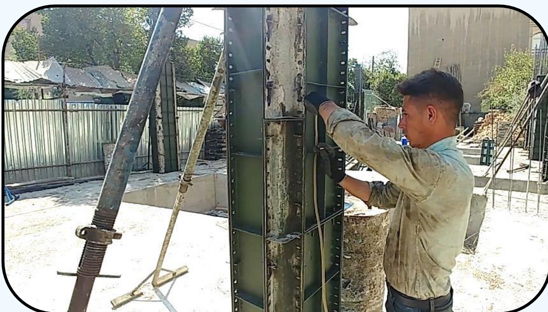
شکل (۲۹-۱۸) شیلنگ تراز ستون‌ها جهت تعیین کد ارتفاعی بتن‌ریزی
