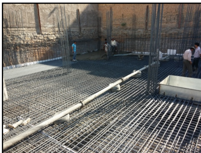
(تصاویری از بتن ریزی فونداسیون با استفاده از پمپ)
