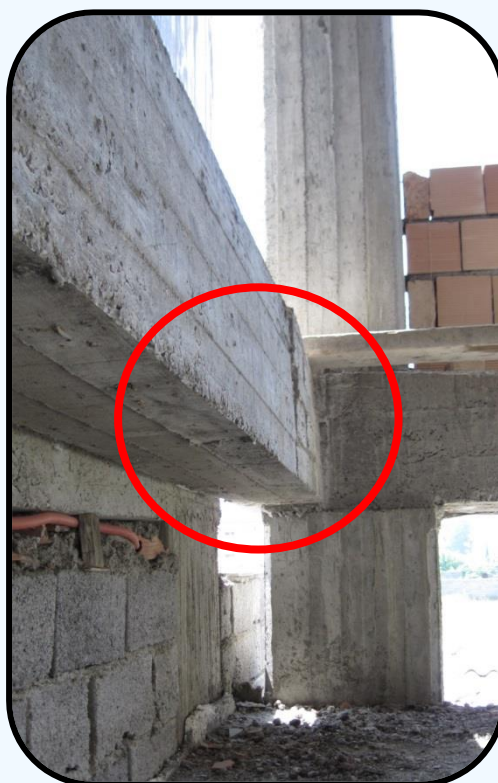
شکل (۳۵-۳۱) برون محور بیش از حد اتصال تیر به ستون
