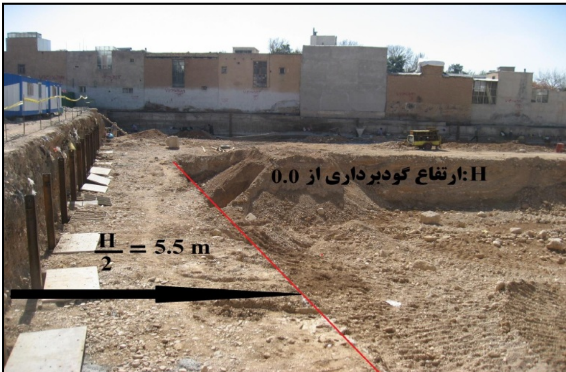
(۶) رعایت فاصله به اندازه نصف ارتفاع خاکبرداری از جداره های گود جهت خاکبرداری باکس وسط تا تراز کف گود
