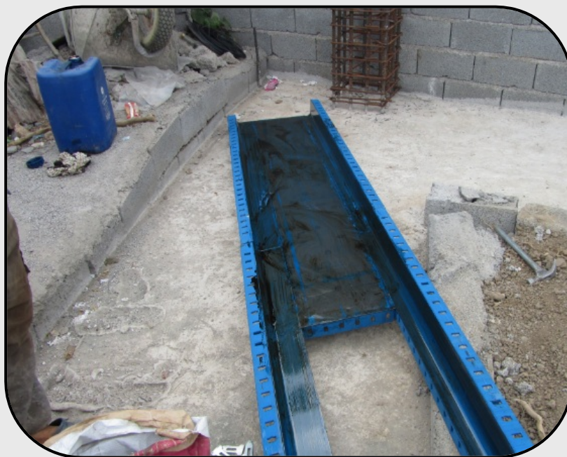
(روغن‌کاری قالب ستون با ترکیبی از روغن سوخته و گازوئیل)
