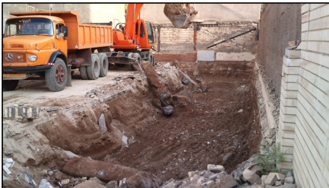
(پی کنی فونداسیون گسترده)
