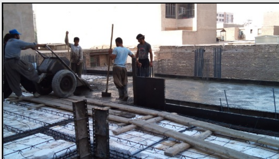
( استفاده از چرخ دستی برای انتقال بتن و هموار کردن مسیر با استفاده از تخته الوار)
