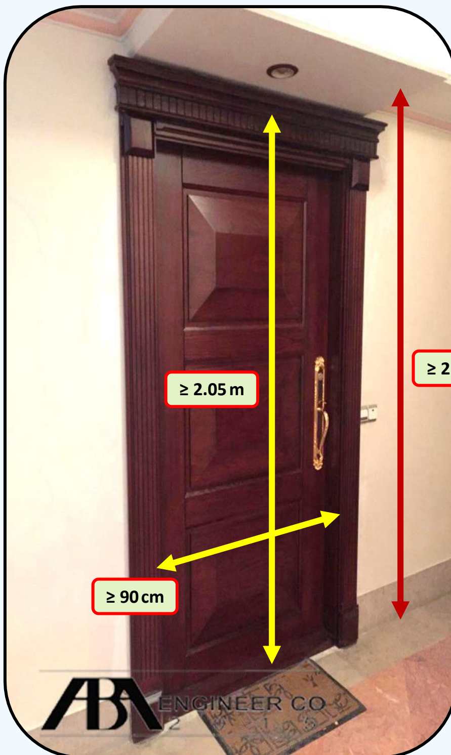
شکل (۴۷-۲) کنترل ابعاد درب ورودی اصلی و فضای ورودی
