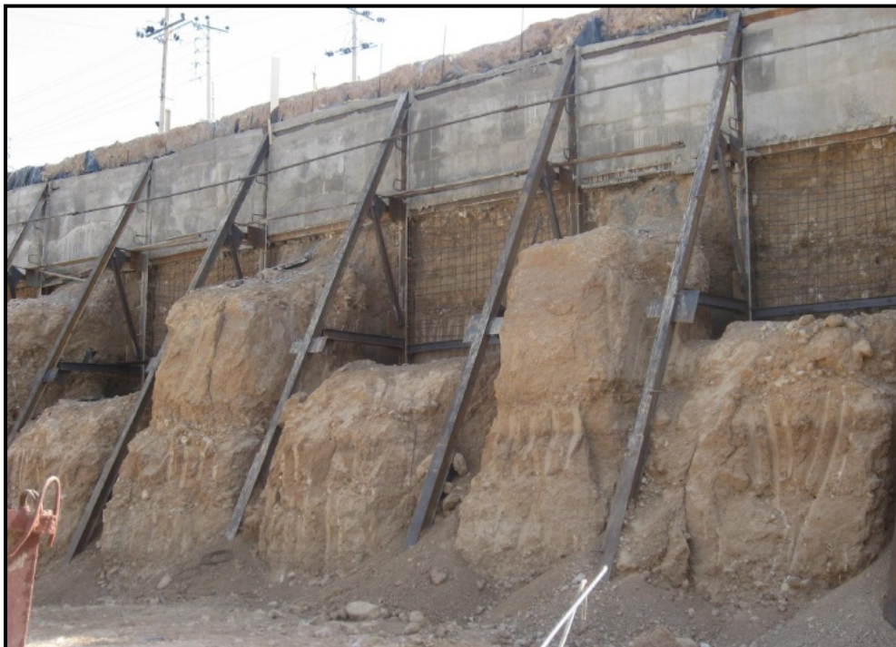
۱۱) خاکبرداری مرحله به مرحله و تکمیل اجزاء سازه نگهدارنده
