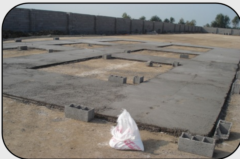
(اجرای بتن مگر)
