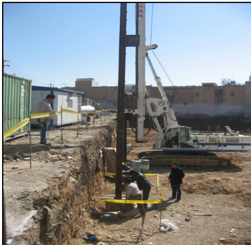
(۴) نصب المان قائم (المان کششی)
