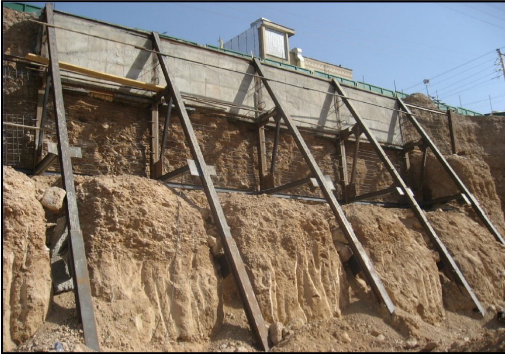
۱۰) آرماتوربندی، قالب‌بندی و بتن‌ریزی
