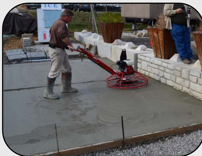
(پرداخت نهایی با ماله مکانیکی)
