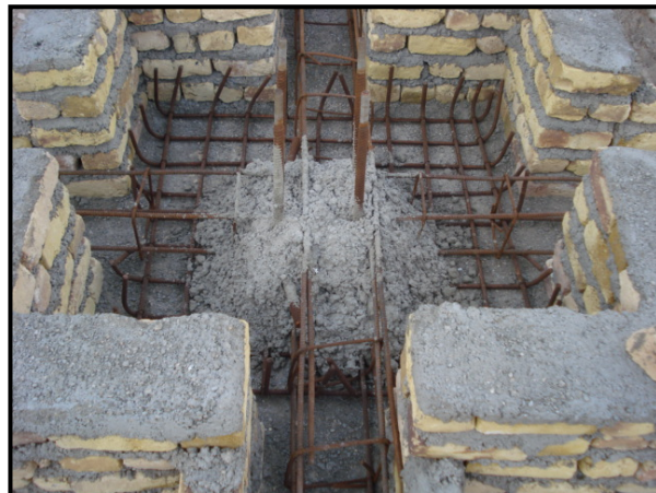
(انباشه شدن و سخت شدن بتن در یک نقطه که در نهایت سبب پدیده درز سرد خواهد شد)
