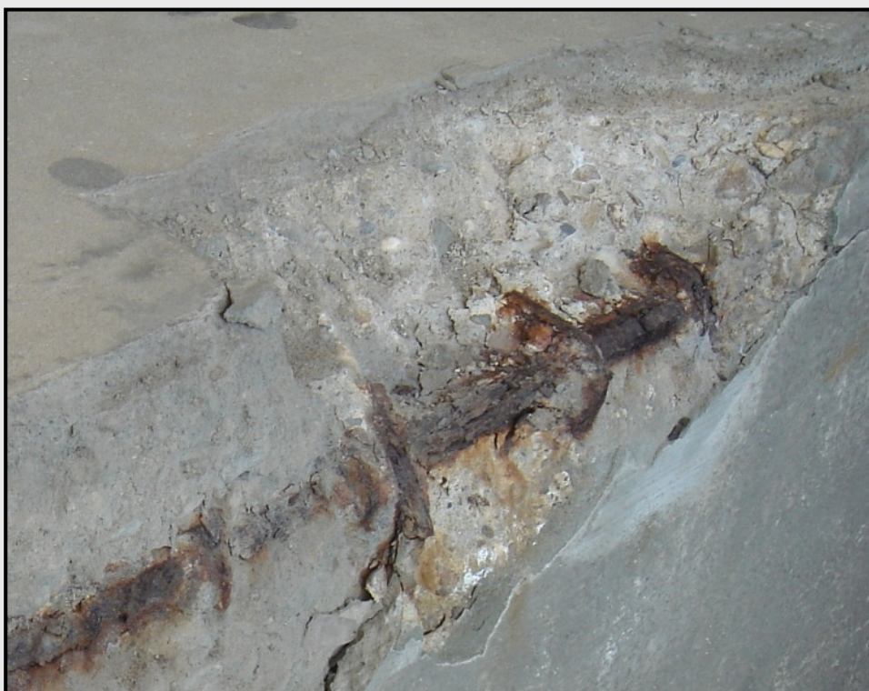
(آسیب بتن و خوردگی میلگرد به علت نفوذ یون سولفات)
