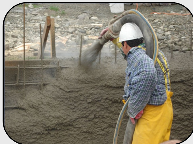
(تصاویری از شاتکریت دیواره استخر)
