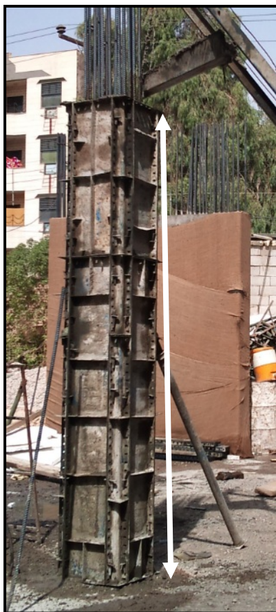
(انحراف از امتداد قائم در قالب‌بندی ستون 6 \leq \Delta \leq 25\text{mm} )
