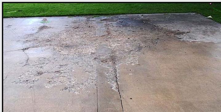
(آسیب‌دیدگی سطح بتن بر اثر سایش)
