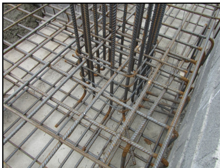
(آرماتورهای انتظار در فونداسیون)
