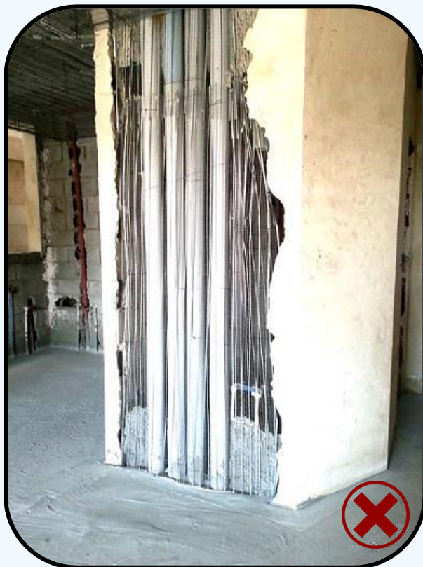
شکل (۳۳-۷۱) تخریب دیوار جهت عبور لوله‌های تاسیساتی
