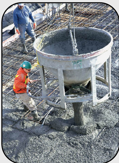
(انتقال بتن با جام و تخلیه آن)
