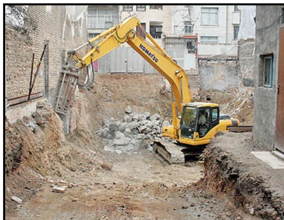
(گودبرداری با بیل مکانیکی)
