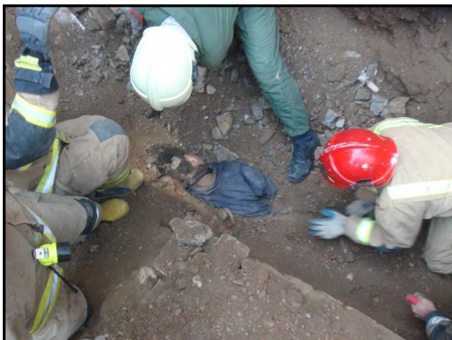
(عدم رعایت اصول گودبرداری و ایمنی که منجر به مدفون شدن کارگر شده است)
