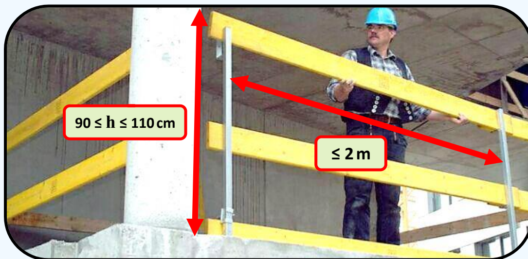
شکل (۳۱-۸۱) نرده حفاظتی موقت کف طبقات
