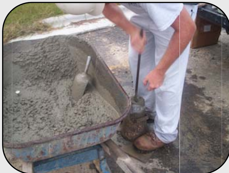
(متراکم کردن بتن با ضربه میله تراکم)
