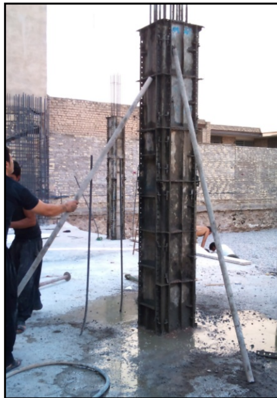
(اجرای نامناسب قالب‌بندی ستون بتنی و نشست شیره بتن از قالب)
