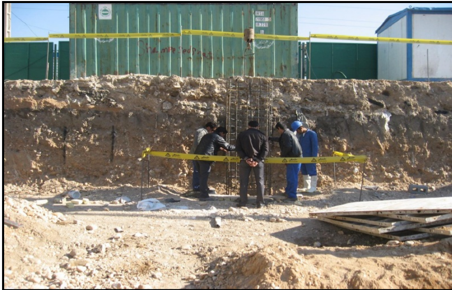
(۳) نصب سبد آرماتور شمع سازه نگهدار
