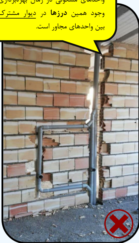
شکل (۳۳-۷۱) تخریب دیوار جهت عبور لوله‌های تاسیساتی
