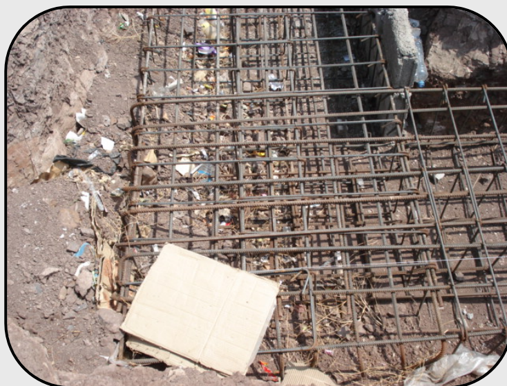
(کیفیت نامطلوب محل بتن‌ریزی)
