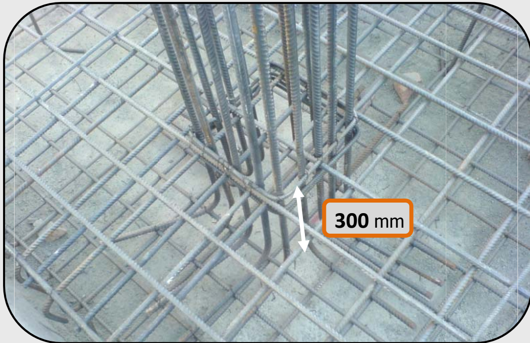
(اتصال آرماتورهای ستون به فونداسیون)
