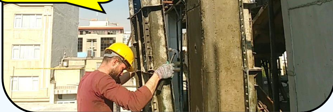
شکل (۲۹-۳۲) باز کردن قالب‌های ستون بتنی
