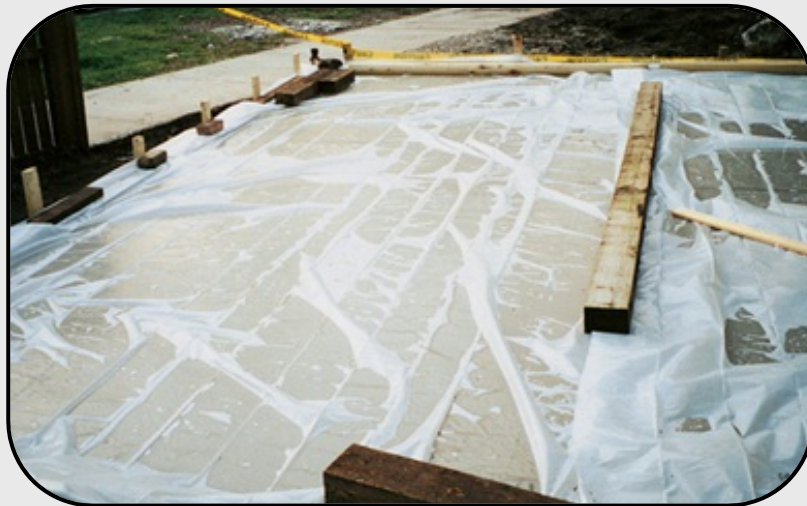
(عمل‌آوری با پوشش پلاستیکی)
