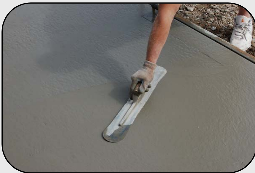
(ملات بیش از حد در جسم بتن)
