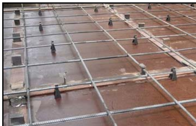
(رعایت پوشش مناسب آرماتورهای سقف با استفاده از اسپیسر)
