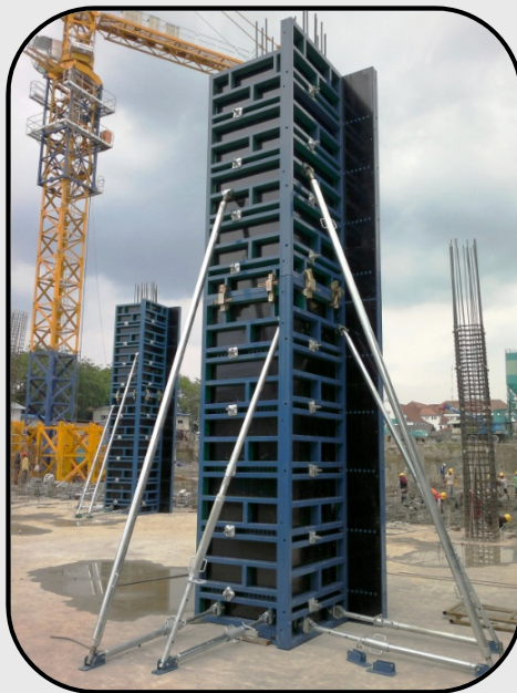
(نمونه‌ای از سیستم سازه‌ای قالب ستون)
