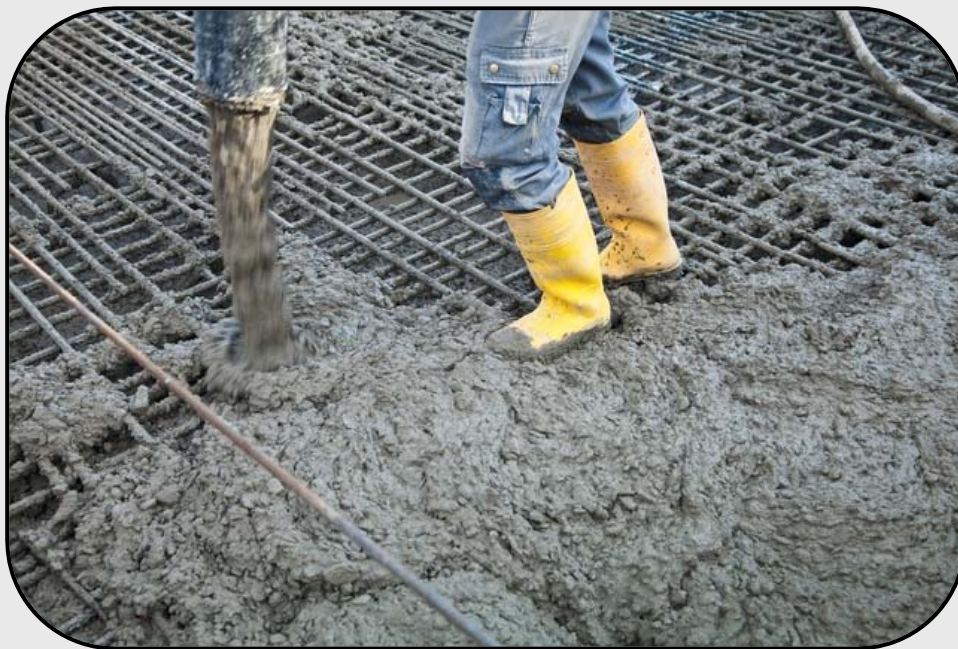
(ریختن بتن در محل نهایی و حالت خمیری بودن آن)
