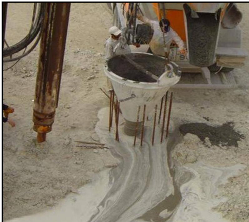
۸) سر ریز شدن بنتونیت بعد از بالا آمدن بتن در هنگام بکاربری گل بنتونیت
