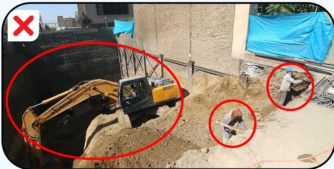
شکل (۱۴-۵) ورود افراد به داخل شعاع عمل بیل مکانیکی
