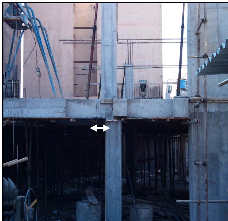
(انحراف ستون از موقعیت مشخص شده در پلان 12 \leq \Delta \leq 25\text{mm} )
