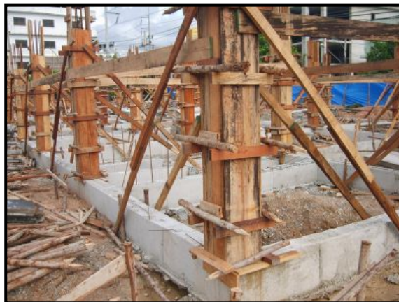
(اجرای قالب چوبی ستون (قالب‌های چوبی در اجرا در حال منسوخ شدن هستند))
