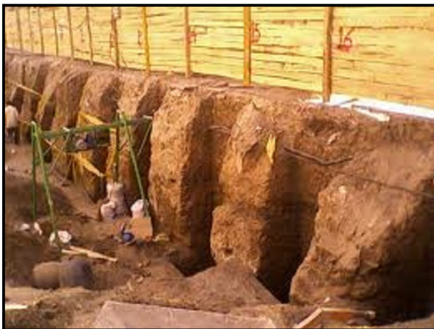
(حفر چاه به فواصل معین در روش مهارسازی)
