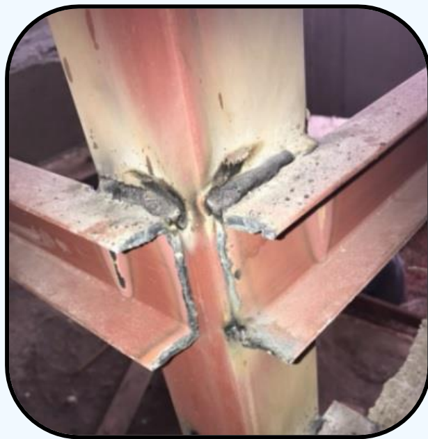
شکل (۲-۳۵) جوشکاری معیوب و غیرقابل قبول نبشی کشی آسانسور
