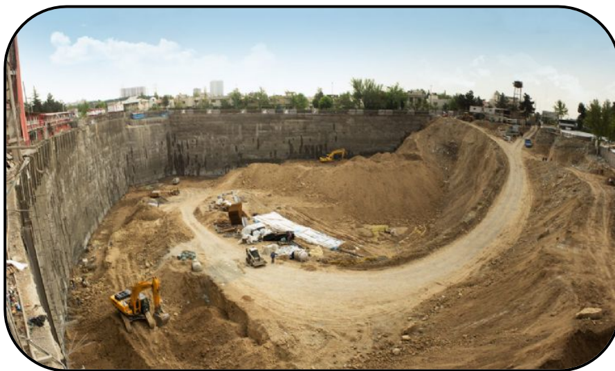
(ایجاد ریمپ برای گودبرداری به منظور سهولت حرکت ماشین‌آلات)
