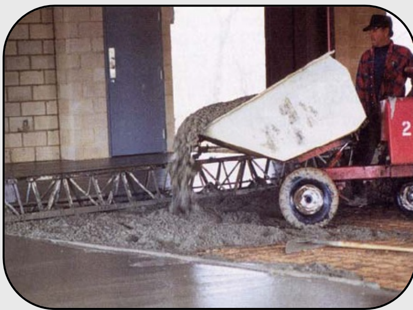
(روش صحیح ریختن بتن)
