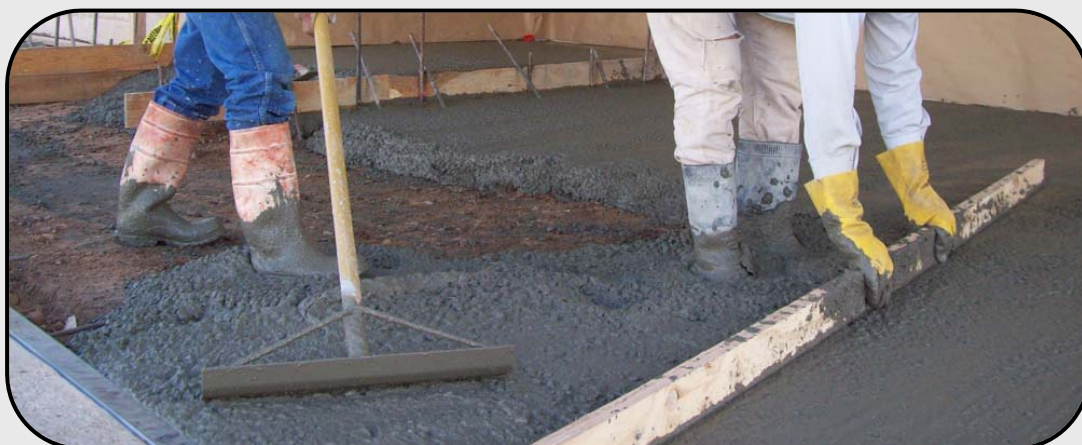
(تی‌کشی سطح بتن)
