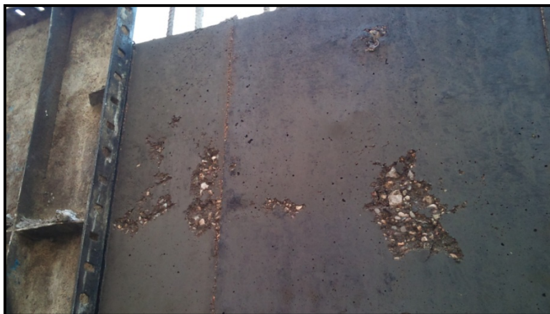
(قالب‌برداری زودهنگام و صدمه دیدن بتن تازه)
