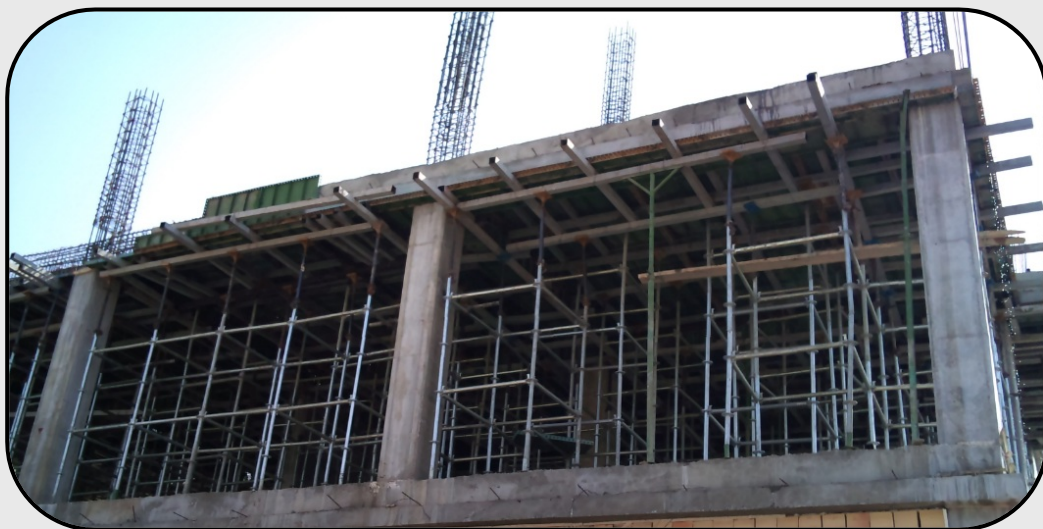
(اجرای داربست دال بتن آرمه)
