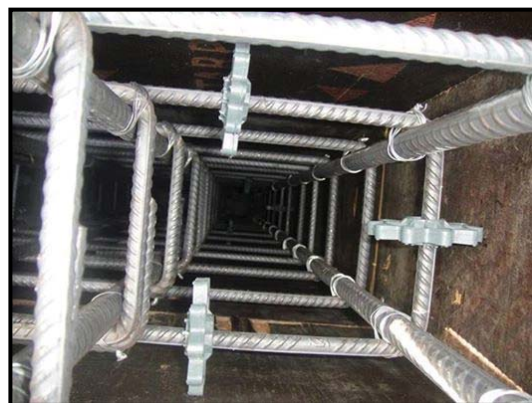
(رعایت پوشش مناسب آرماتورهای دیوار برشی با استفاده از اسپیسر)
