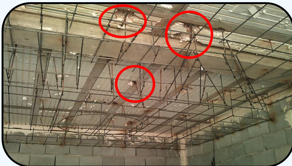
شکل (۴۰-۱) تخریب تیرچه و اتصال میلگردهای سقف کاذب به میلگردهای تیرچه
