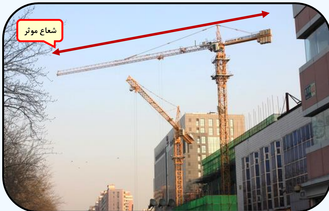
شکل (۱-۷۷) نمایش شعاع موثر در جرثقیل‌های برجی (تاورکرین)
