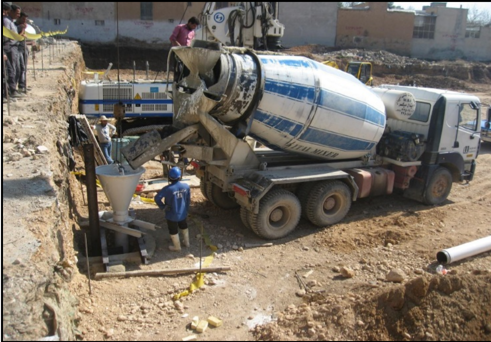
(۵) بتن ریزی شمع سازه نگهبان
