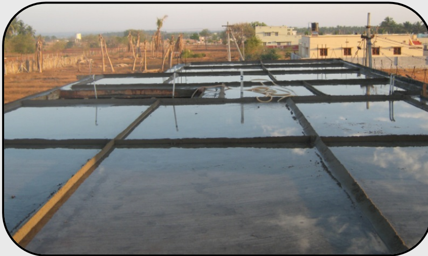
(عمل آوری با ایجاد حوضچه آب بر سطح افقی بتن)
