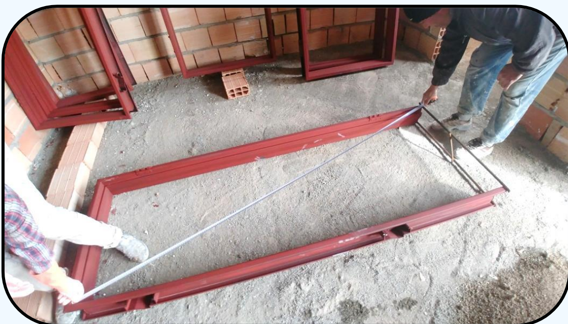
شکل (۷-۳۴) کنترل ابتدایی پیچیدگی چارچوب در با اندازه گیری ضربدری
