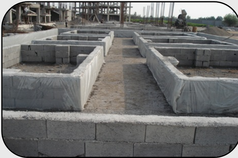
(تعبیه پوشش پلاستیکی دیواره قالب‌بندی فونداسیون)
