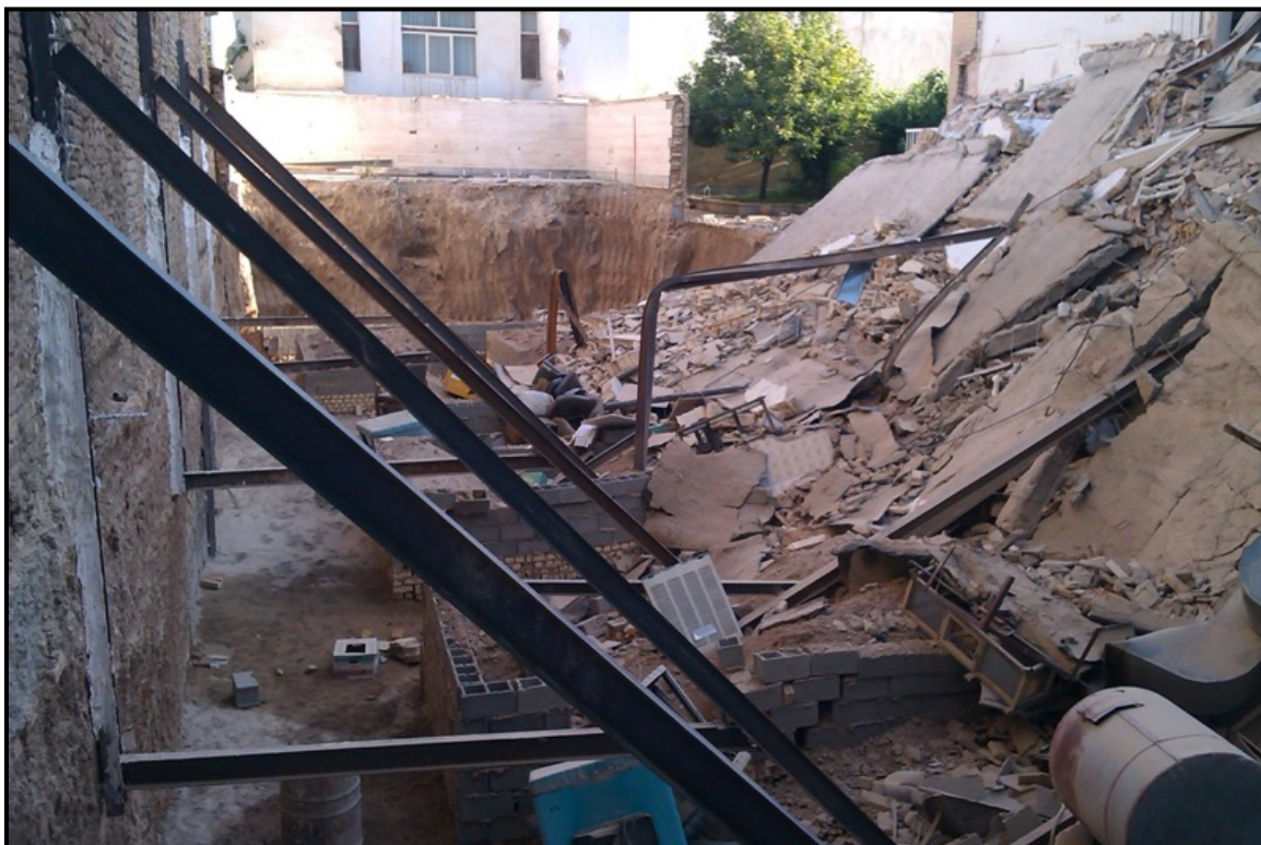
(ریزش ساختمان مجاور به دلیل عدم رعایت اصول پایدارسازی گود با خرابی حائل)
