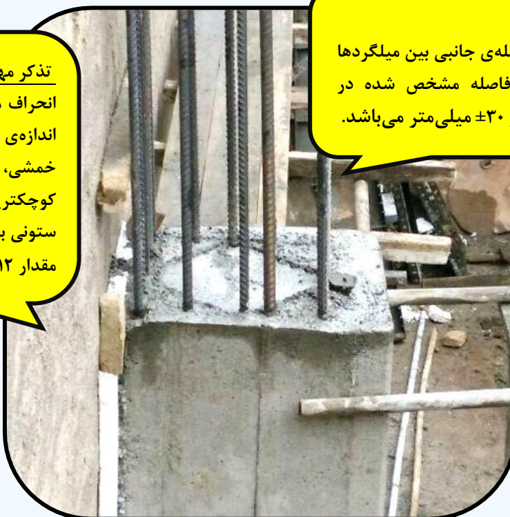
شکل (۲۹-۳۳) عدم رعایت رواداری انحراف میلگردهای ستون
