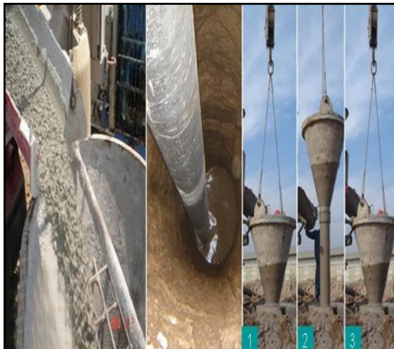
۴) بالا و پایین کردن ترمی جهت تخلیه بتن درون آن
