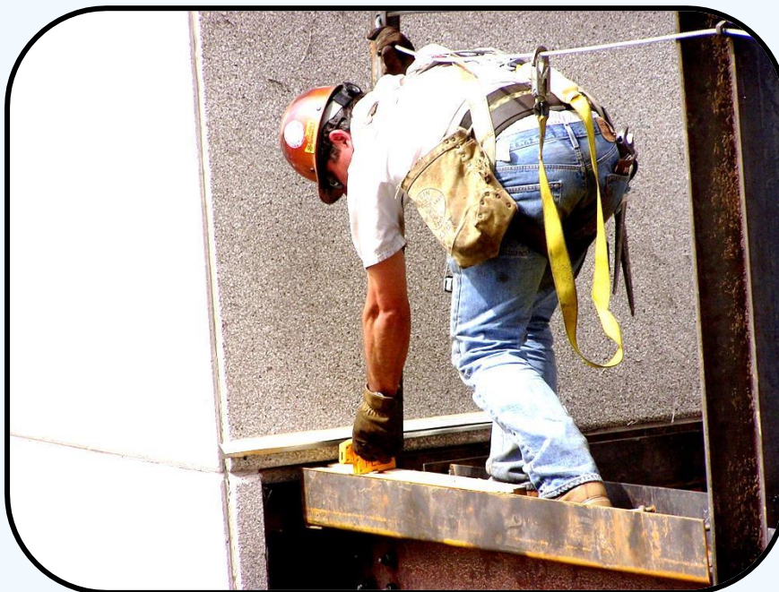
شکل (۲-۸۲) استفاده از لایف‌لاین جهت ایمنی کارگران در ارتفاع
