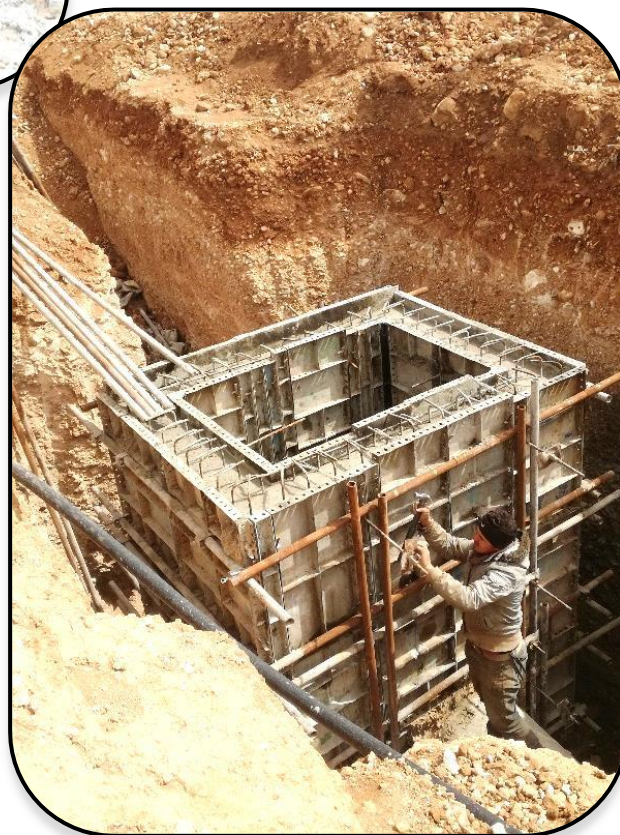
قالب بندی و بتن ریزی منهول بتن درجا
