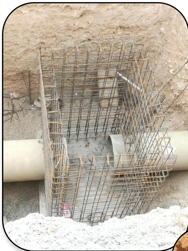
آرماتوربندی منهول بتن درجا
