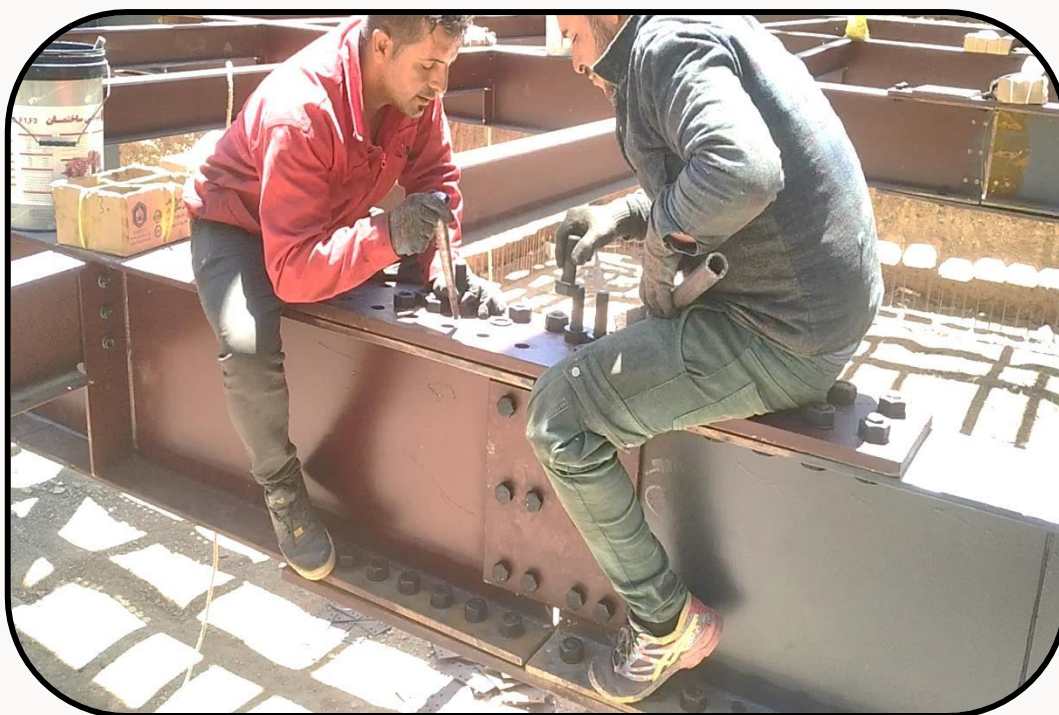
شکل (۱۵-۳۱) منطبق کردن سوراخ‌ها با استفاده از سمبه فلزی
