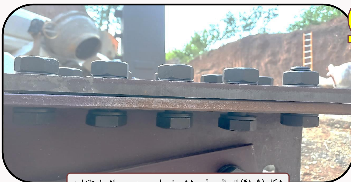
شکل (۹-۴۸) اتصال ورق پوششی تیر با پیچ، مهره و واشر استاندارد
