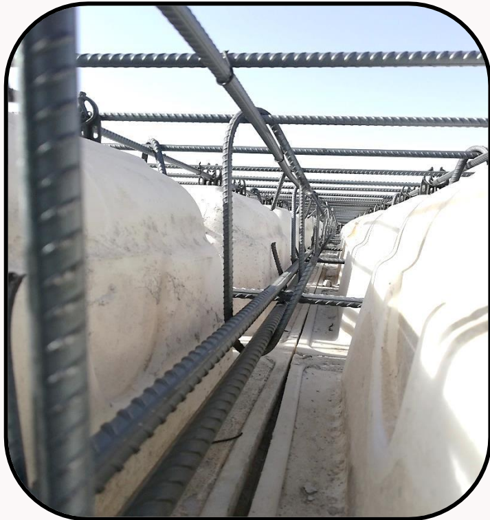
شکل (۵۱-۲۰) آرماتوربندی بین قالب‌های سقف وافل
