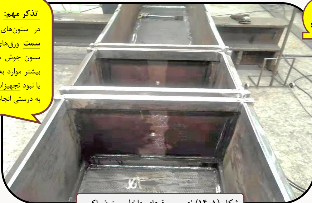
شکل (۸-۱۴) نصب ورق‌های داخلی ستون باکس
