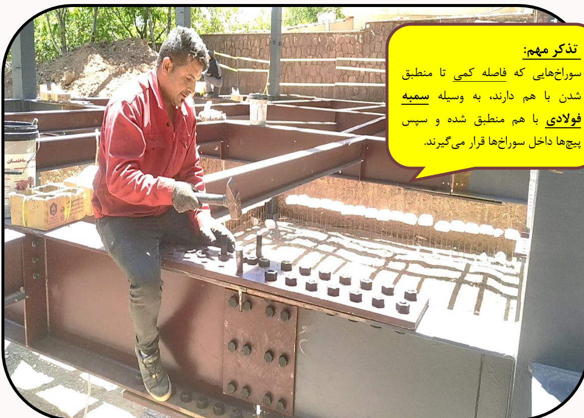
شکل (۱۵-۳۲) وارد کردن سمبه داخل سوراخ با ضربه پتک
