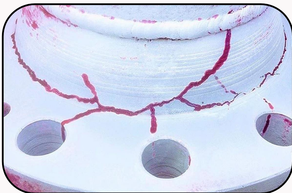
شکل (۹-۲۳) خطوط قرمز نشان‌دهنده ترک سطحی
