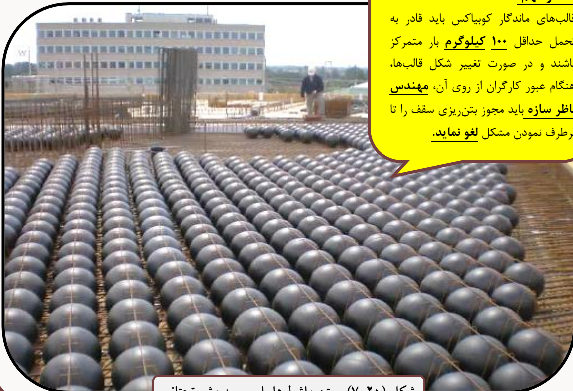
شکل (۷-۲۰) بستن ماژول‌ها با سیم به مش تحتانی
