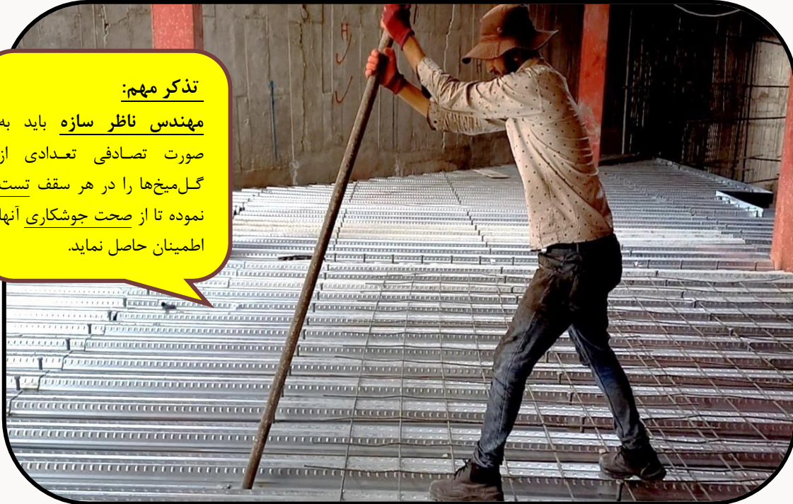
شکل (۱۹-۵۳) تست جوش گل‌میخ‌ها توسط لوله فلزی در کارگاه
