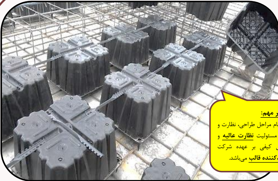
شکل (۲۰-۲۴) قراردادن قالب‌های یوبوت روی سقف مطابق با نقشه‌های سازه
