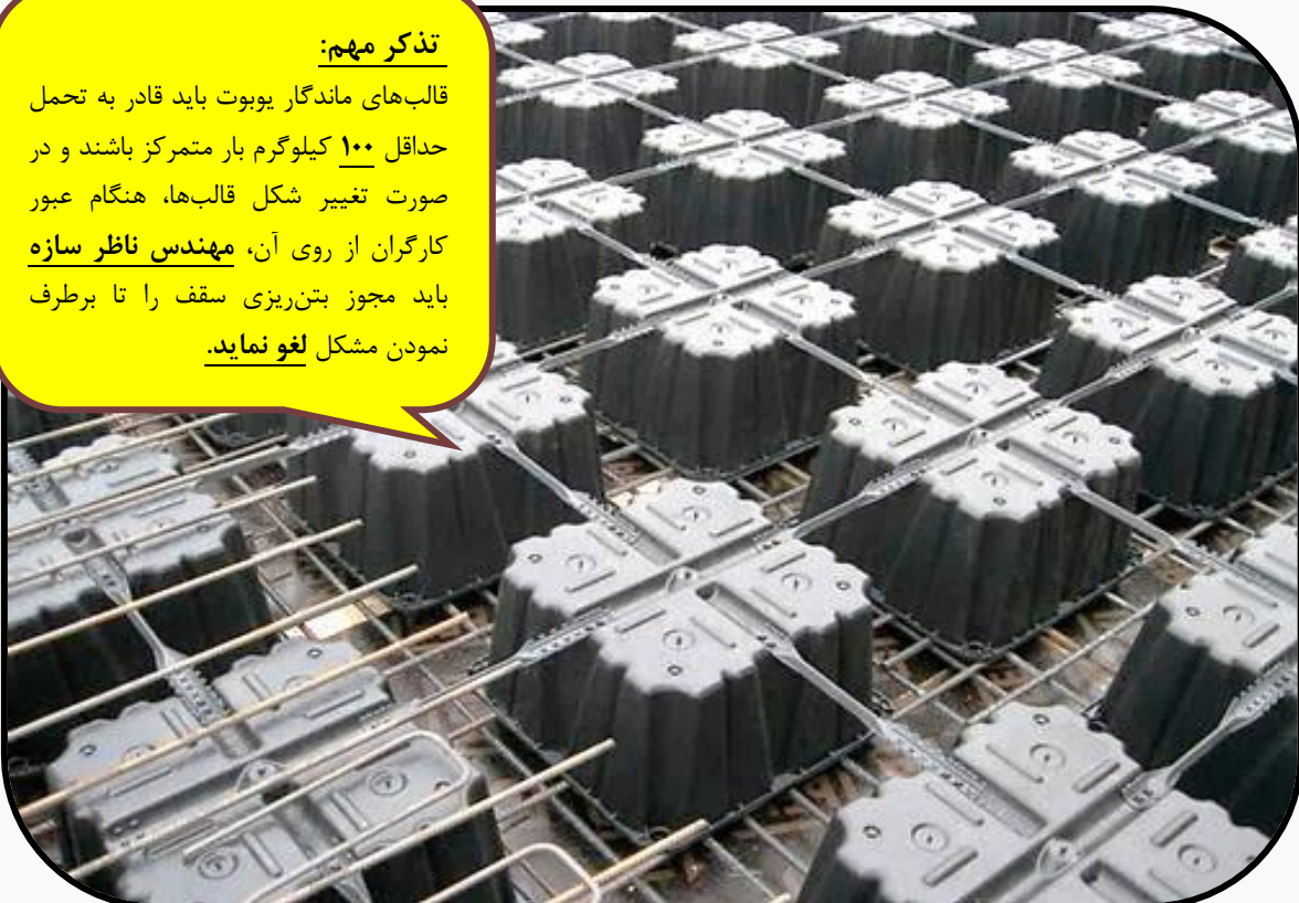
شکل (۲۰-۲۵) نصب تسمه‌های پلاستیکی در چهار طرف قالب‌ها
