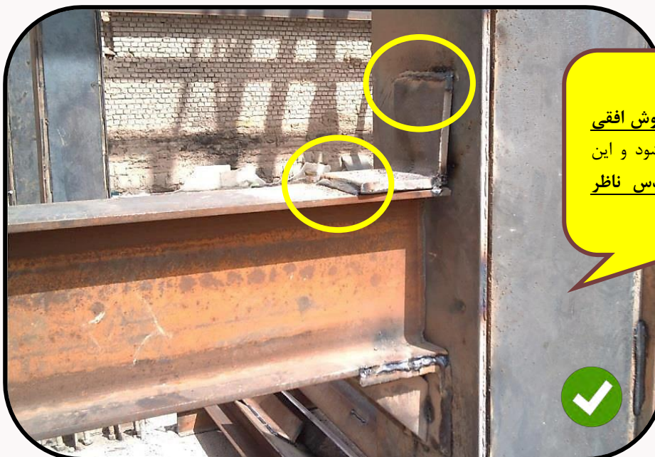
شکل (۱۵-۷۲) اتصال مفصلی با نبشی نشیمن
