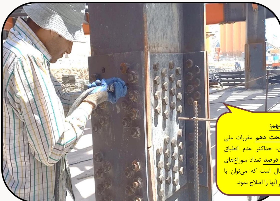
شکل (۹-۴۵) منطبق کردن سوراخ‌ها با برق‌زنی در اتصال ورق پوششی ستون
