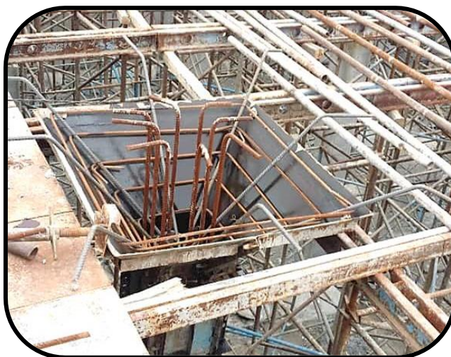
شکل (۱۵-۵) قالب‌بندی فلزی ستون و سرستون
