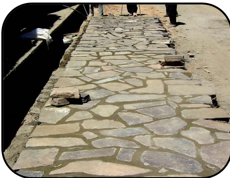
شکل (۳-۴) بنایی با سنگ تخته‌ای
