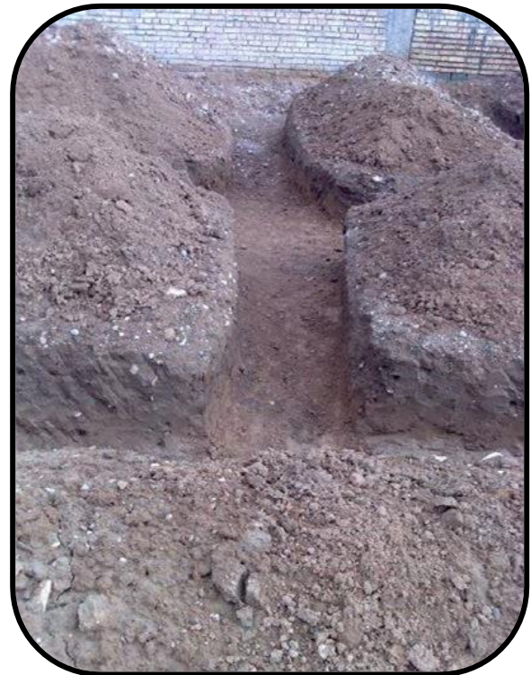
شکل (۵-۲) پی کنی فونداسیون نواری
