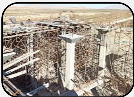
شکل (۶-۶) بتن ریزی ستون و سرستون
