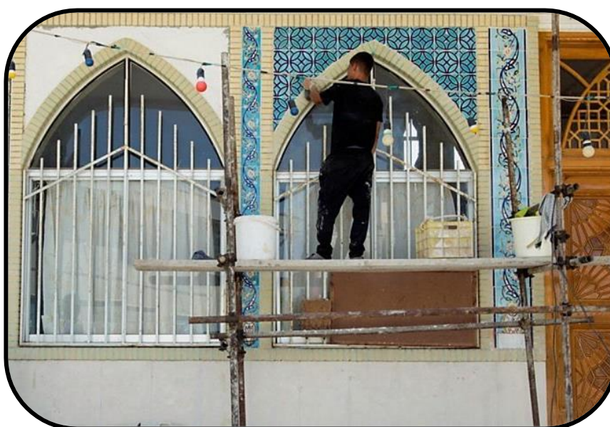
شکل (۶-۱۷) کاشی کاری
